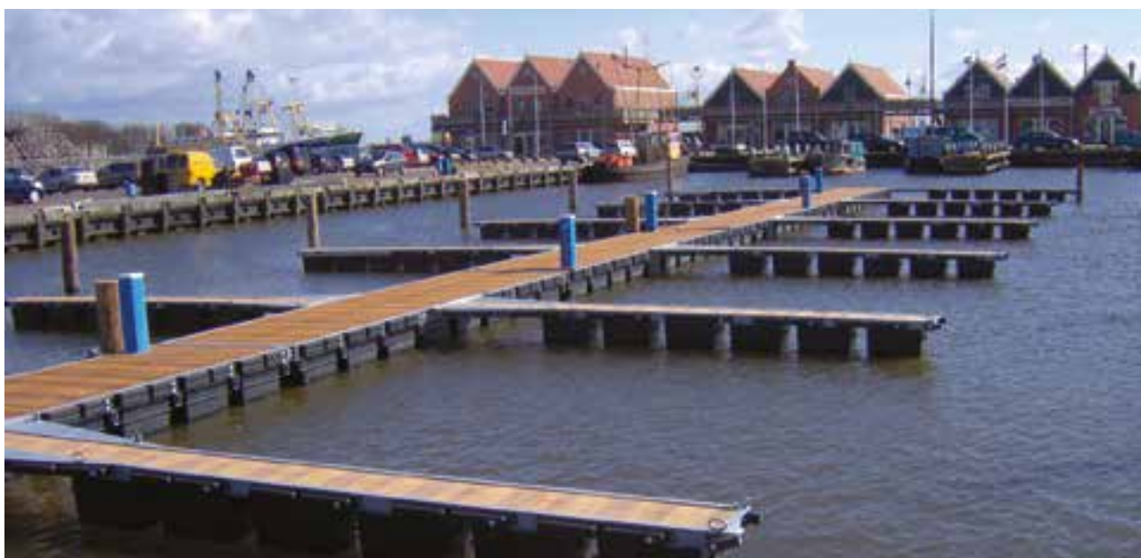
▲ Photo 75 : Ponton de plaisance © WIJMA
