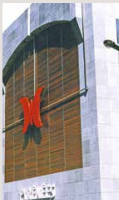
▲ Photo 34 : Aménagement de façade en bardage bois © M. Vernay
