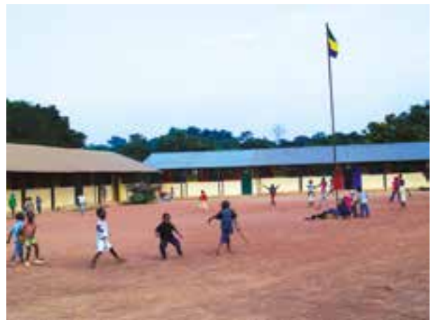
▲ Photo 25 : Ecole construite par une entreprise FSC © B. Demarquez TERE
