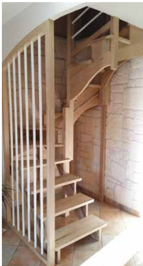
▲ Photo 44 : Escalier © P. Garcia, MD CREATION
