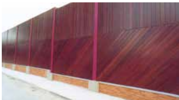
▼ Photo 64 : Ecrans acoustiques réfléchissants sur voie routière © M. Vernay
