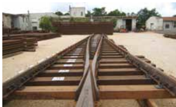
▲ Photo 68 : Traverses d'une ligne d'aiguillage © WIJMA
