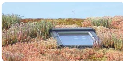
UNE TOITURE QUI VARIE SELON LES SAISONS
