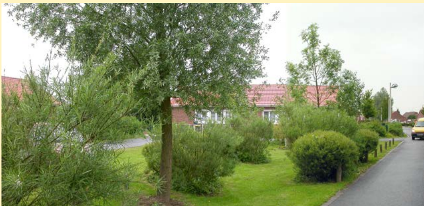
1 - Un délaissé de voirie a été ici aménagé en zone tampon pour stocker les eaux pluviales (large noue). Outre son rôle fonctionnel, cet espace planté participe à la qualité du cadre de vie des riverains.
