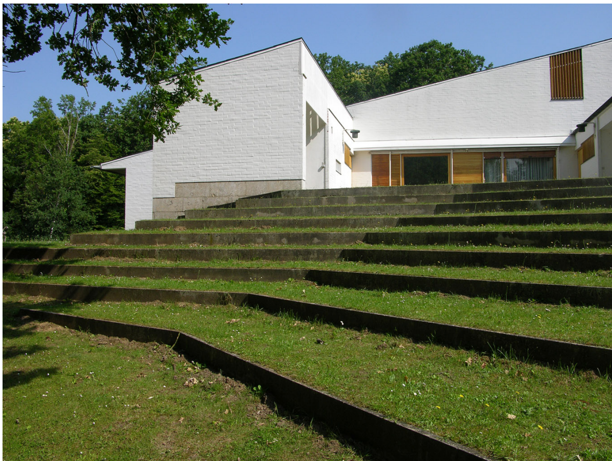
Alvar Aalto (1898-1976), Maison Louis Carré , 1957-1950, environ 4 ha, Bazoches-sur-Guyonne (Yvelines).
