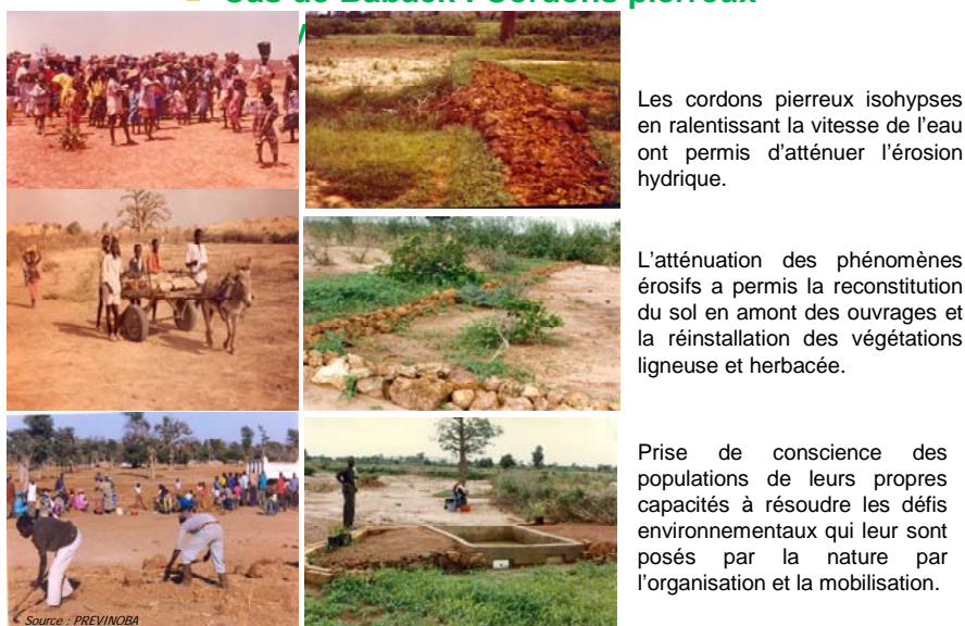
Photo 5 : Aménagements de CES dans la partie Nord de la zone arachidière (Sénégal)
