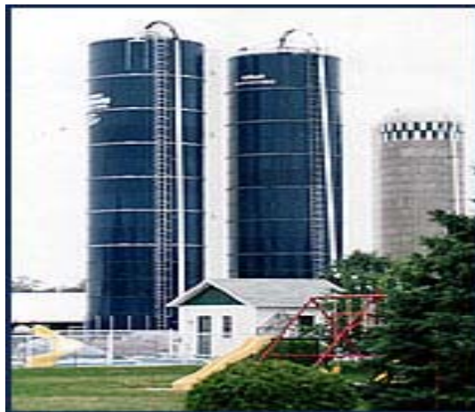
Photo 19: Silos à revêtement vitrifié utilisés pour le maïs humide
