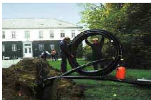
Conduites flexibles pré-isolées Source: Urecon Ltée. ( www.urecon.com )
