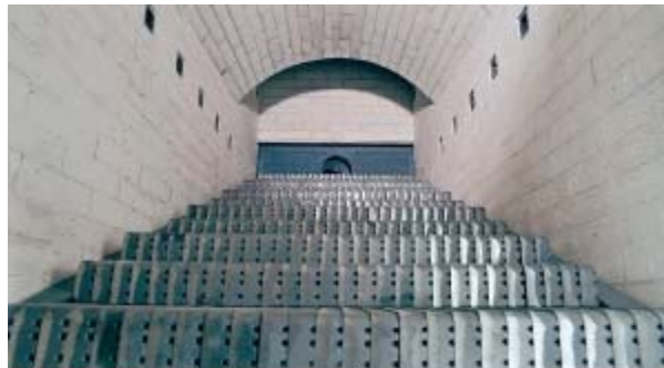
Photo 23 : Chambre de combustion en escalier
