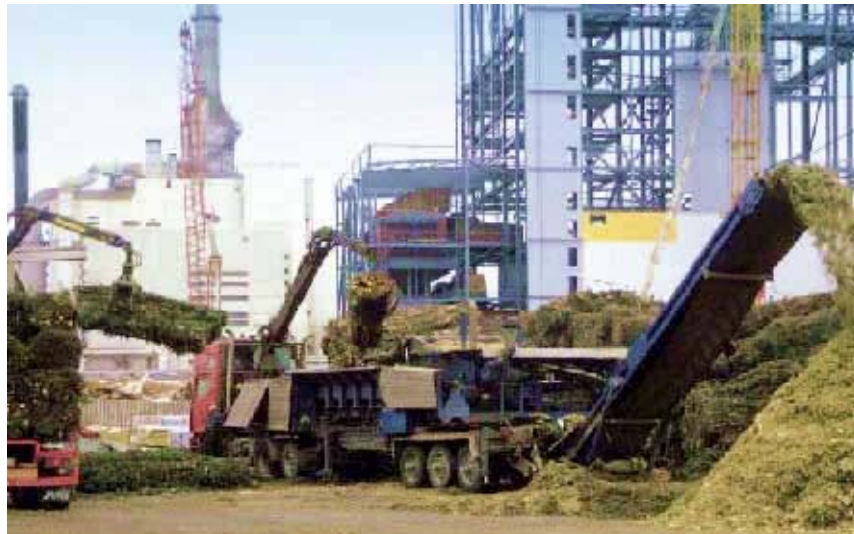
Photo 9 : Broyage en plaquettes avec des équipements fixes sur le site de l'unité productrice d'énergie
