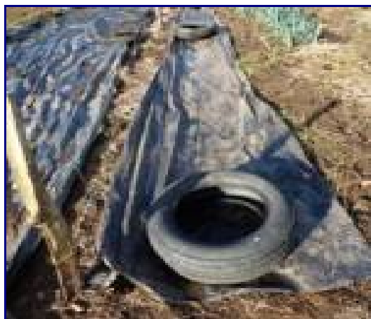
Préparation du sol
