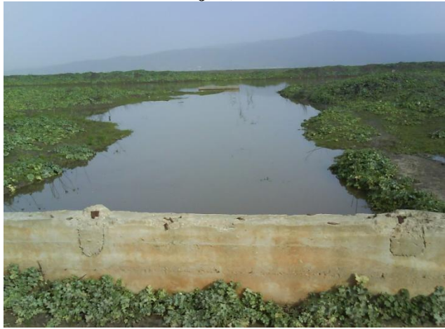
Photo 03 : Canal de drainage secondaire (Sud du lac). Le 02/02/2009.
