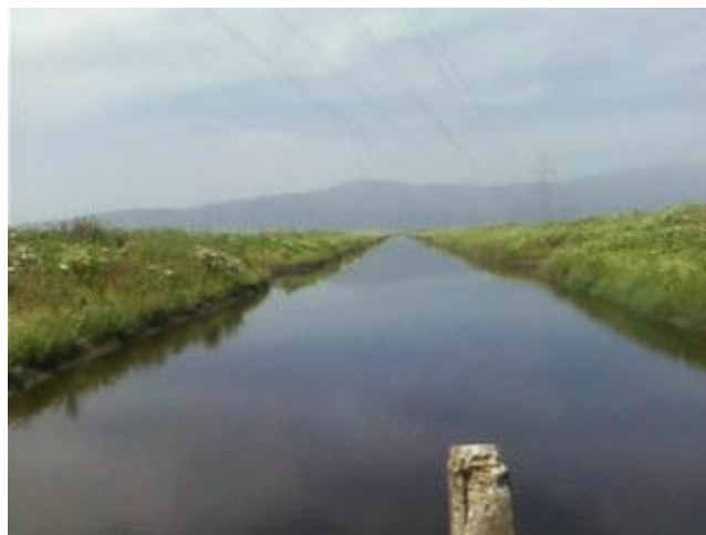
Photo 01: Canal principal (Sud du lac Fetzara). Le 02 /02/2009.
