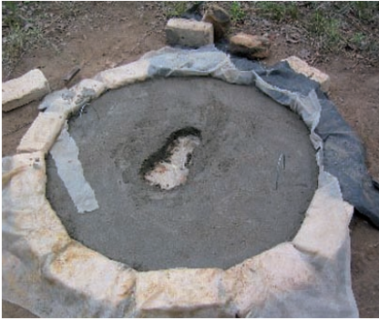
Photo 3-9 : Le moule après le retrait des briques d'insertion du trou de défécation.
