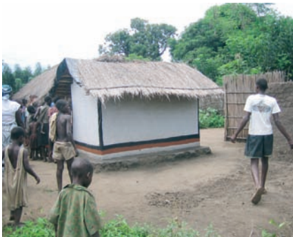
Photo 4-3 : Une superstructure permanente couvrant les deux fosses en même temps.
