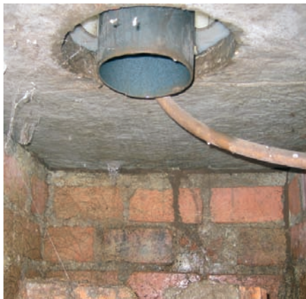
Photo 7-14 : Le tuyau d'urine placé sous la dalle
