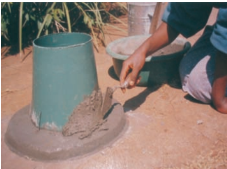
Photo 5-1 : Construction du siège à faible coût.
