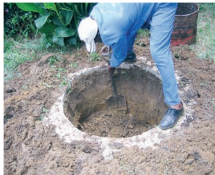
Photo 3-36 : Creusement de la fosse à l'intérieur du soubassement de béton.
