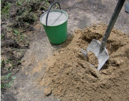
Photo 3-24 : Mélange du ciment au sable mélange
