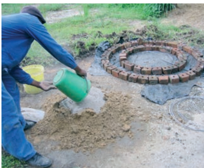
Photo 3-29 : Mélange de ciment et de sable mélange
