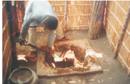
Photo 4-22 : Evacuation de l'humus de la fosse
