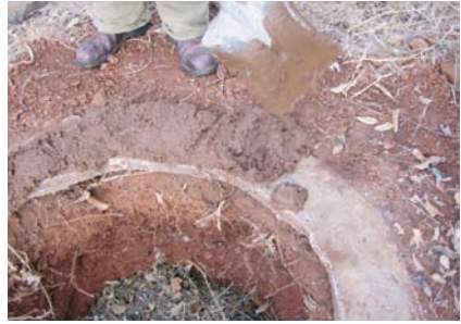
Photo 3-48 : Mortier étalé sur le soubassement.
