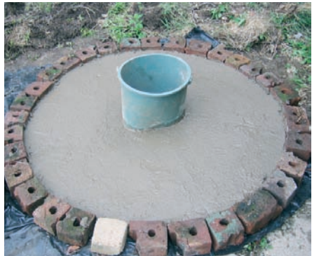
Photo 3-27 : Ajout du reste de mélange de béton et son nivellement.
