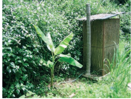
Photo 6-32 : L'extérieur d'un cabinet de latrine à séparation d'urines.
