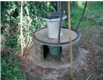
Photo 7-5 : Dalle et siège posés sur une base
