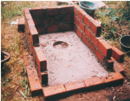
Photo 6-3 : Construction de la fosse avec des briques posées sur leurs flancs.
