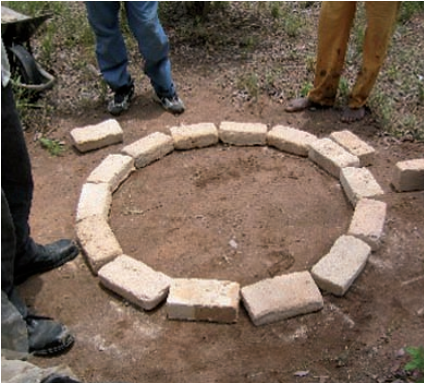
Photo 3-5 : Ceinture de briques pour le moule.
