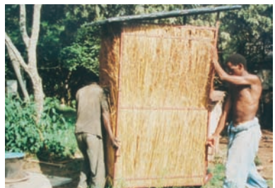
Photo 3-58 : Une structure mobile bâtie sur une armature d'acier
