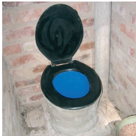
Photo 5-12 : Siège réalisé à bas prix avec la partie assise en plastique.
