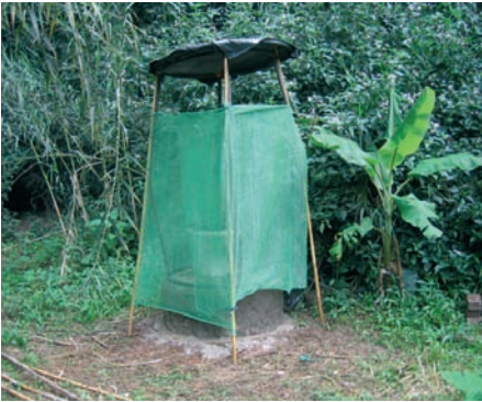
Photo 7-7 : Superstructure autour d'une latrine améliorée.
