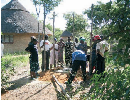
Photo 3-37 : Utilisation de poteaux pour la construction de la superstructure.
