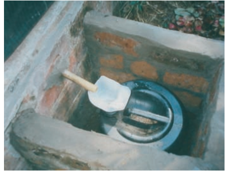
Photo 6-38 : Le récipient en plastique où retombent les urines déviées
