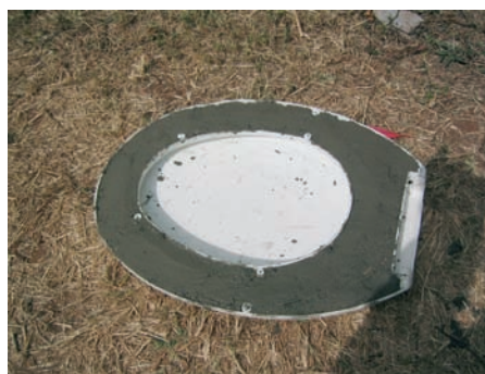
Photo 6-17 : Béton ajouté au siège de latrine
