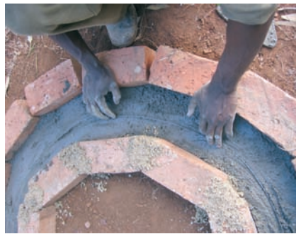
Photo 3-44 : Ajout de fils de fer pour le renforcement.
