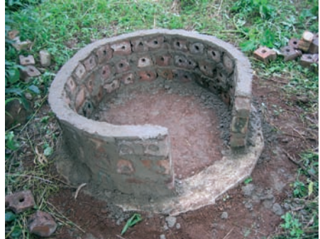
Photo 7-4 : Mur de brique bâti sur le soubassement
