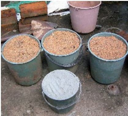
Photo 3-7 : Comment mesurer le ciment et le sable mélange.
