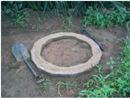
Photo 7-3 : Soubassement posé sur un terrain plat
