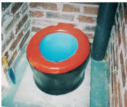
Photo 5-6 : Siège de béton finalisé
