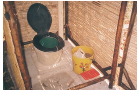
Photo 4-18 : L'intérieur d'une Fossa alterna équipée d'un siège
