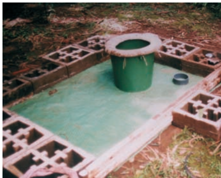
Photo 6-2 : Le coffrage de briques pour la dalle de la latrine
