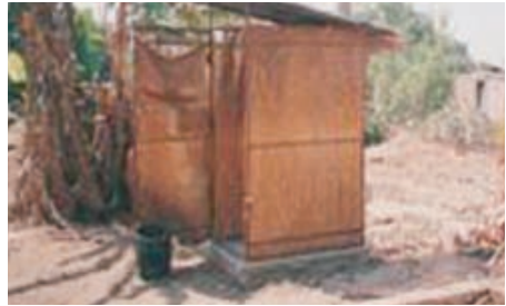
Photo 4-20 : Une Fossa alterna après la deuxième année
