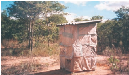
Photo 3-57: Une structure mobile bâtie sur une armature de poteaux.
