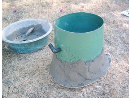
Photo 6-20 : Béton ajouté à mi-hauteur du seau
