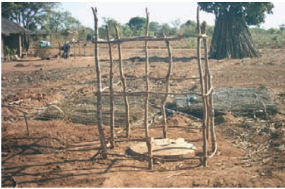
Photo 3-53 : Une structure simple faite de poteaux et d'herbes
