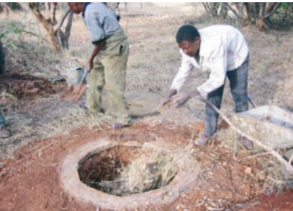
Photo 3-47 : Ajout de feuilles à la fosse
