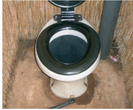
Photo 7-2 : Système de récupération des urines fixé à la base d'un siège
