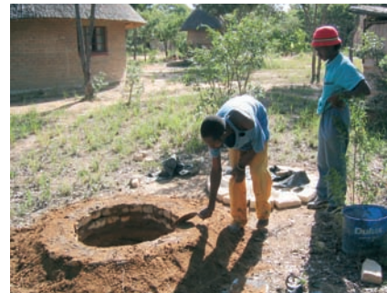
Photo : 3-34 : Elévation du niveau du sol autour du soubassement de briques
