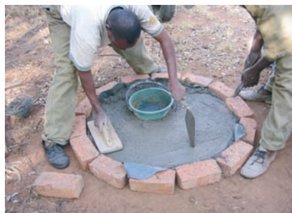
Photo 3-42 : Nivellement du mélange de béton
