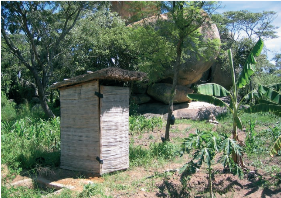
Photo 13-1 : Eco-latrine à Ruwa, au Zimbabwe
