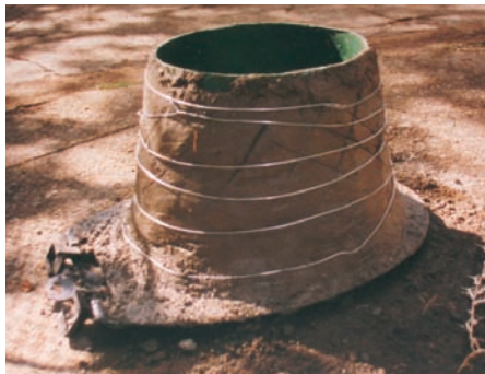
Photo 5-10 : Renfort de béton rajoutée à la première couche de béton
