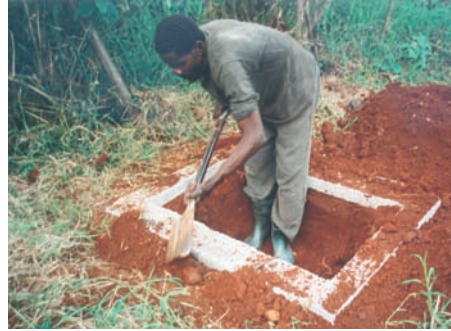
Photo 4-10 : Creusement de la fosse pour la Fossa alterna
