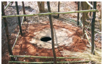
Photo 3-50 : Poteaux en bois et paille pour construire le mur.
