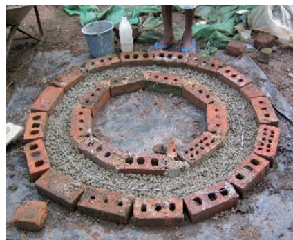
Photo 3-15 : Renfort de ciment et de l'armature dans le moule.
