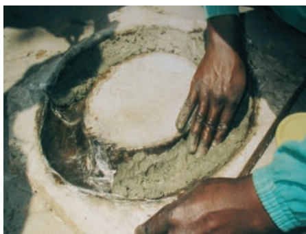
Photo 5-3 : Ajout de béton au moule du siège
