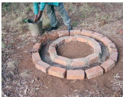
Photo 3-43 : Utilisation de briques pour faire le soubassement.
