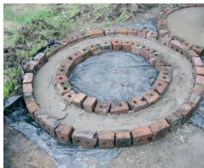
Photo 3-30 : Mélange de béton dans le moule
