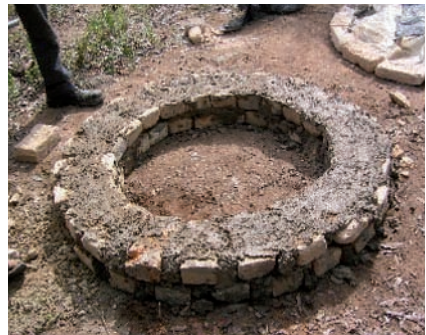
Photo 3-12 : Finalisation du soubassement en briques.
