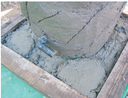
Photo 6-23 : Fil de fer supplémentaire pour le renforcement
