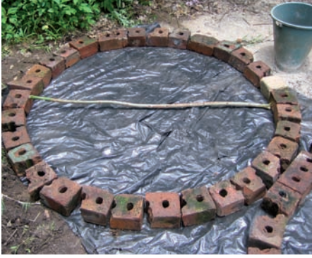
Photo 3-22 : Le moule pour la dalle de 1,15 m de diamètre
