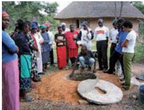
Photo 3-21: Des stagiaires en construction de latrines au village de Kufunda.
