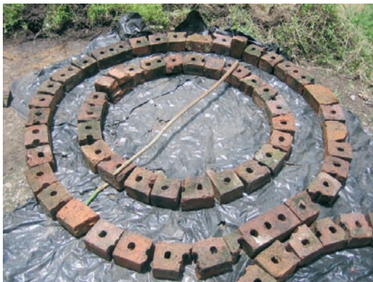
Photo 3-28 : Deux cercles de briques pour constituer le moule du soubassement.
