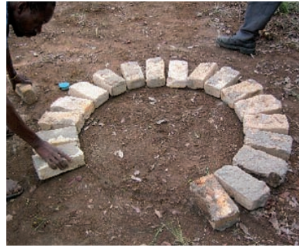
Photo 3-10 : Réalisation du soubassement en briques.
