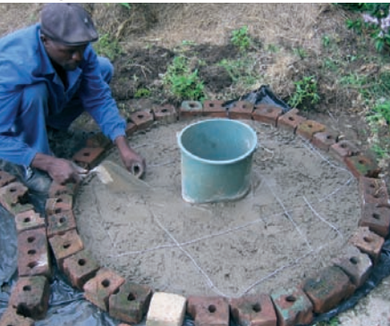
Photo 3-26 : Ajout d'armature pour renforcer.
