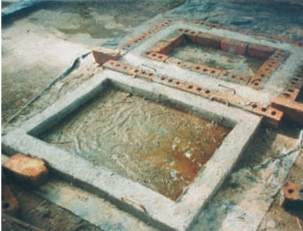
Photo 4-9 : Coffrage de soubassement en briques.
