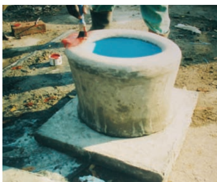
Photo 5-5 : Peinture du siège de béton
