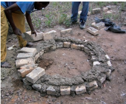
Photo 3-11 : Ajout de la deuxième couche de briques avec le mortier.
