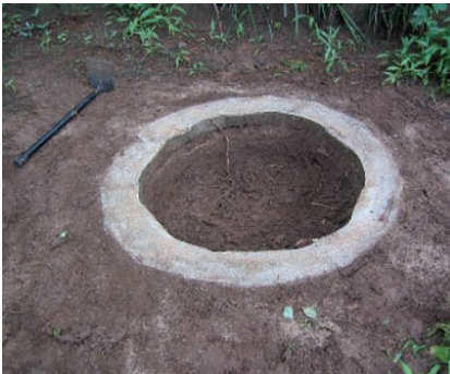
Photo 3-18 : Creusement du trou à l'intérieur du soubassement.
