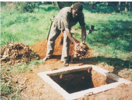
Photo 4-11 : Ajout de feuilles dans la fosse de la Fossa alterna
