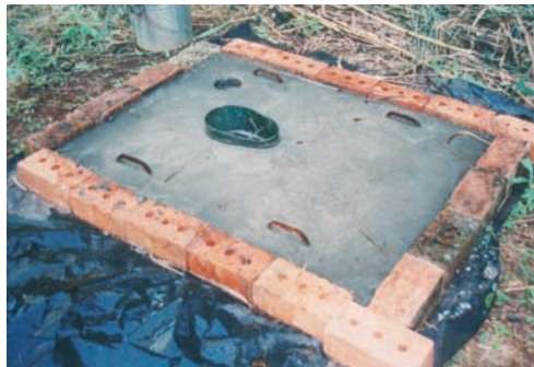
Photo 4-7 : La dalle finalisée à l'intérieur du moule.
