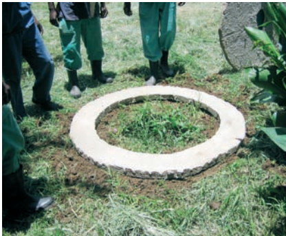
Photo 3-35: Placement du soubassement de béton
