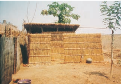
Photo 4-21 : Une Fossa alterna avec structure permanente
