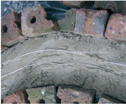
Photo 3-31: Ajout de fils de fer pour renforcement.
