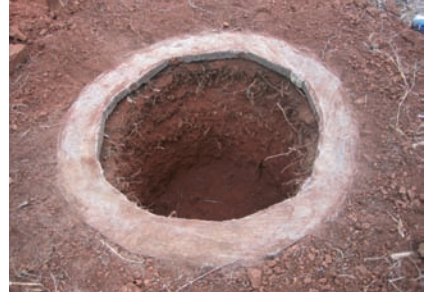
Photo 3-46 : Une fosse creusée à l'intérieur du soubassement.
