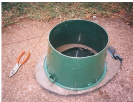
Photo 5-9 : Seau en plastique placé au-dessus du siège de la latrine
