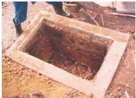
Photo 4-12 : Une Fossa alterna terminée
