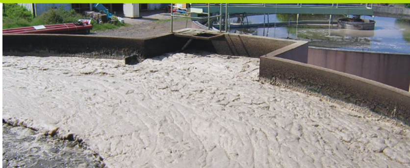
Traitement biologique des eaux usées générant les boues (Saint-Leu). © V. van de Kerchove
