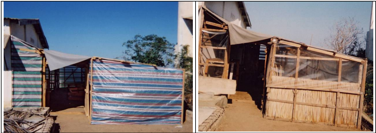
Bassin de culture (première construction et après réhabilitation)
