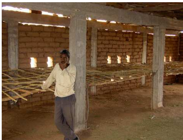
Photo 4 : Séchoir en béton
