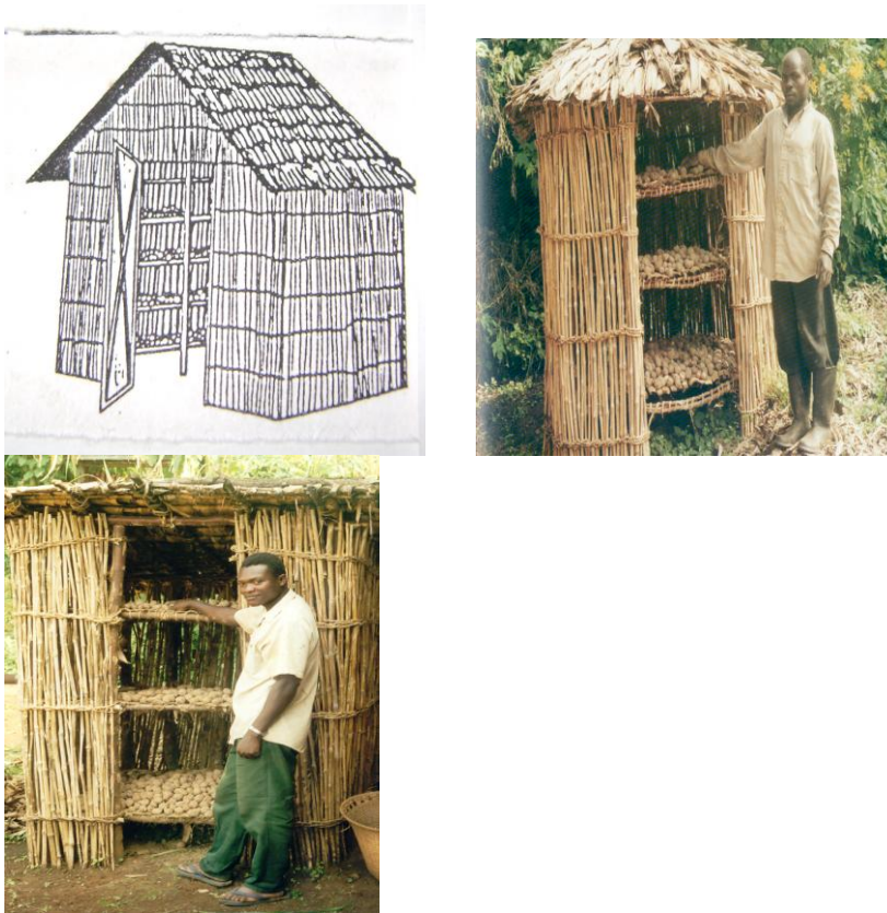
Figure. Magasins de stockage de pomme de terre construits en matériaux locaux
