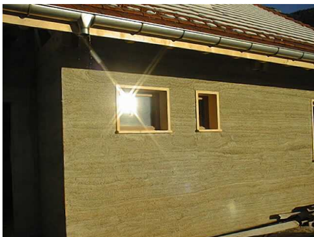
Maison en béton banché de chanvre
