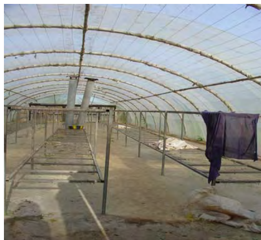
Photographie n°2: tunnel de séchage utilisé par le GFPFL à Foulayah.
