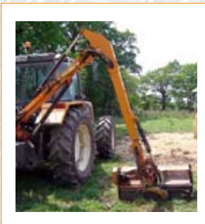
Débroussaillage avec épareuse
