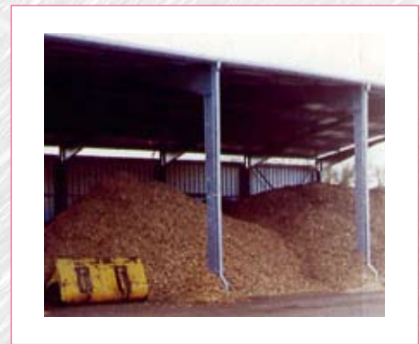
Plateforme de stockage
