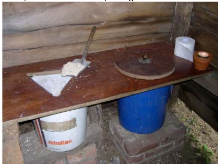
Illustration 16 : Un abri, de la sciure, un seau confortablement encadré : les toilettes sèches ou W.W.C. (Without Water Closed) est un dispositif propre et écologique très facile à mettre en place.
