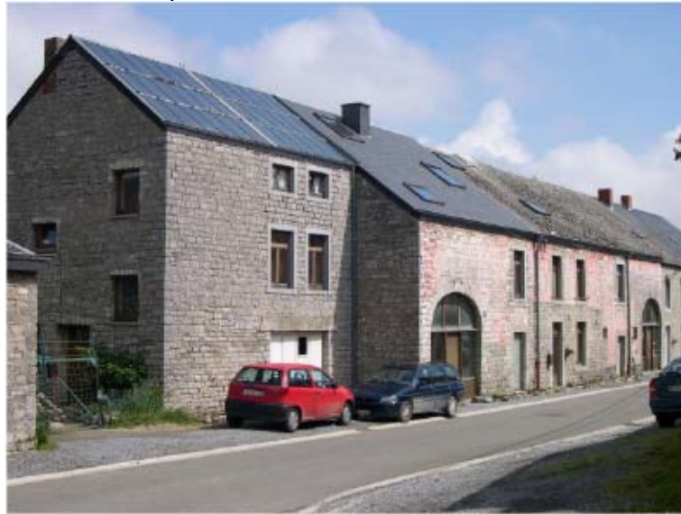
Illustration 3 : L'été, l'eau chaude est produite grâce à une surface de panneaux solaires thermiques sur le toit de la ferme. L'hiver, c'est le système de chauffage central au bois qui prend le relais.
