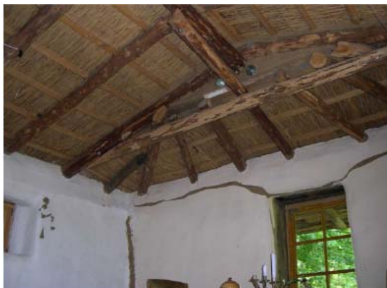
Illustration 14 : Vues de l'intérieur douillet de la petit maison. On peut voir l'isolation du toit en chaumes ainsi que la charpente de bois reposant sur les murs montés en bottes de pailles.
