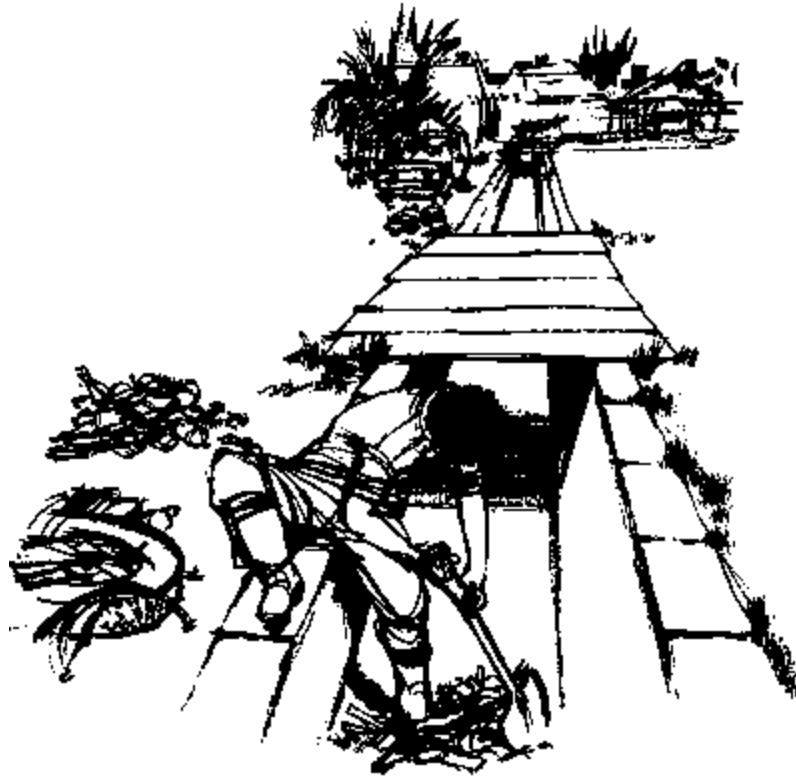
Fig. 1.128. Il faut éliminer les saletés et les débris divers qui font obstacle à l'écoulement de l'eau dans les réseaux de drainage.
