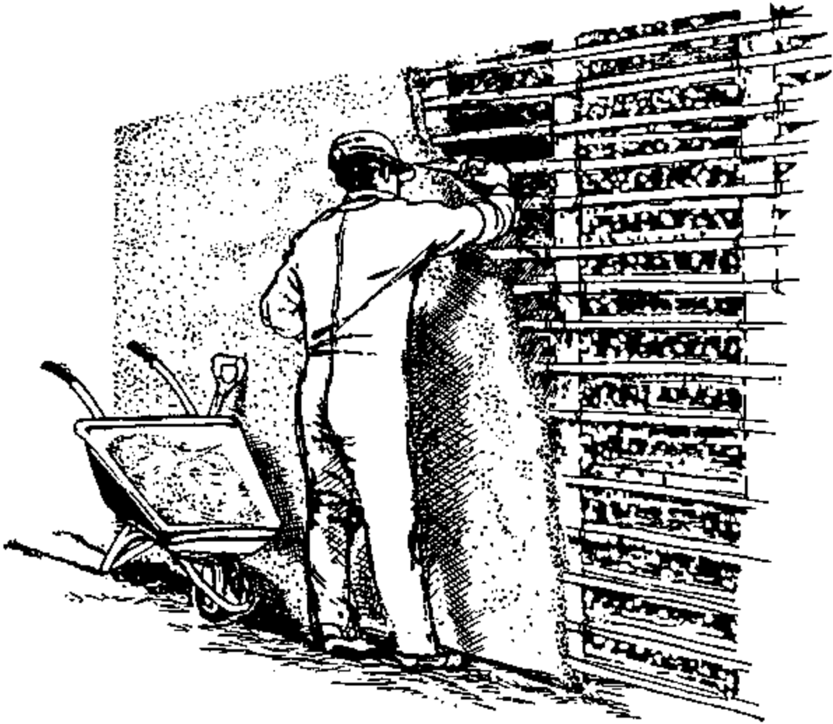
Fig. 3.16 Les lieux de repos constitués par les anfractuosités des murs peuvent être éliminés grâce au crépissage des murs au moyen d'un enduit qu'on peut mettre en place à la main puis lisser soit à la main, soit avec une truelle.
