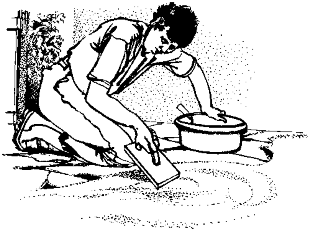
Fig. 3.19 Les lieux de repos offerts aux réduves par le sol peuvent être bouchés puis recouverts d'une chape de ciment.
