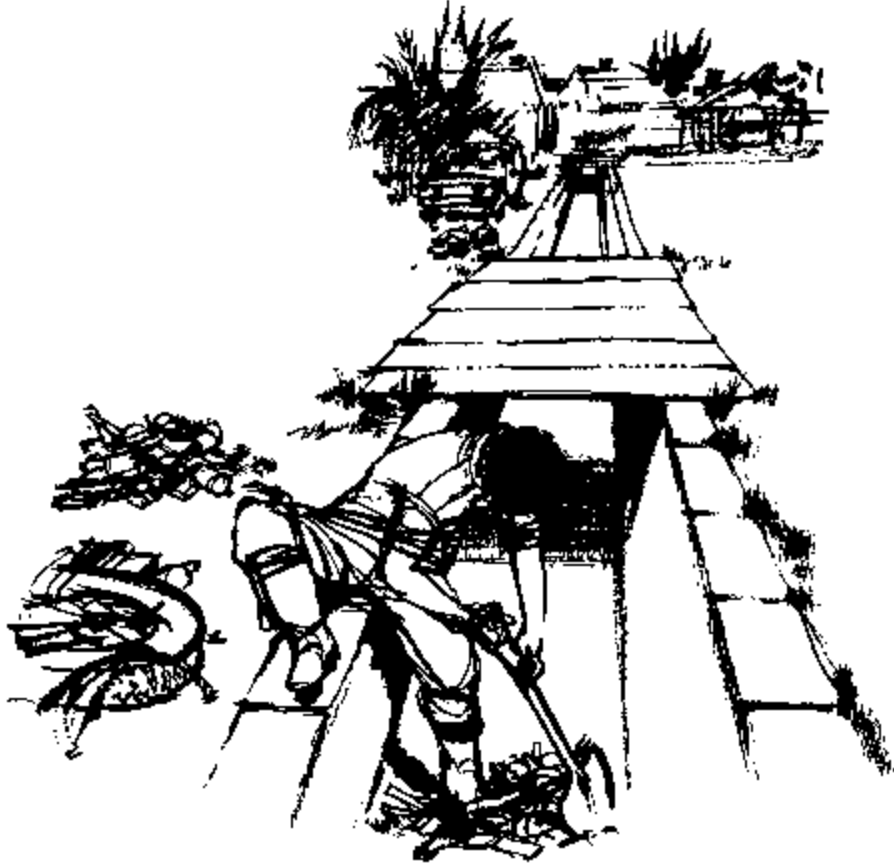
Fig. 6.10 Le curage régulier des caniveaux et des fossés est indispensable pour empêcher la reproduction des mouches dans les débris organiques qui s'y accumulent.
