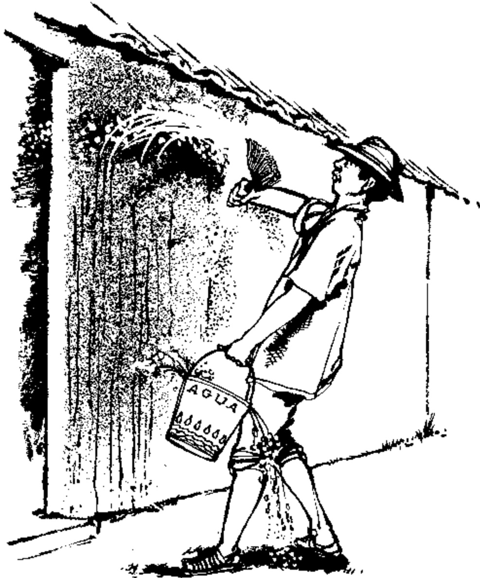
Fig. 3.17 Il faut humecter la surface avant d'appliquer la couche d'enduit suivante pour en augmenter l'adhérence et éviter la formation de fissures provoquée par un séchage trop rapide.
