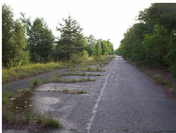
Début de colonisation et dégradation de l'asphalte par une flore spontanée, sur la partie forestière d'une autoroute polonaise non terminée et peu utilisée (Olimpijka)
