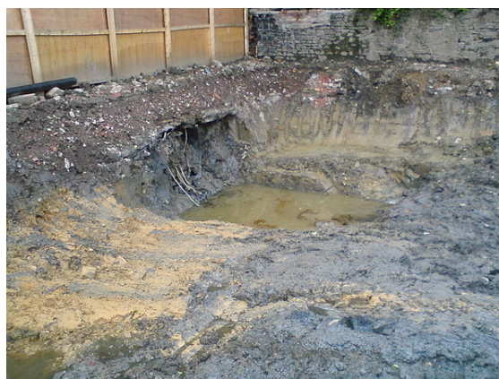
Décassement d'un sol pollué par un réservoir de goudron
