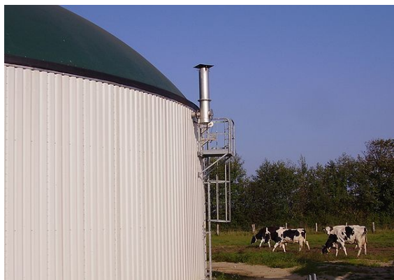
Application agricole d'un digesteur d'ensilage de maïs situé près de Neumünster en Allemagne (2007). Un réservoir de biogaz (en vert) est placé sur le sommet du digesteur
