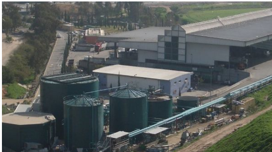
Digesteurs anaérobies : Tel-Aviv (Israël)
