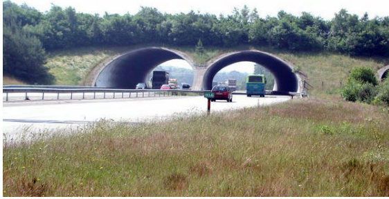
Écoduc de type « Passage supérieur », enjambant les 4 voies de l'A 50 aux Pays-Bas
