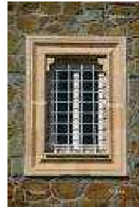
Fenêtre à barreaux
