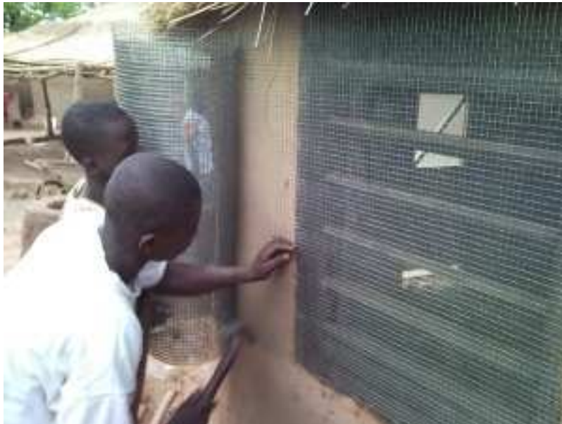
Le artisans installe un matériel anti-moustiques sur les fenêtres www.greenhouseghana.com/index.php?page=pictures
