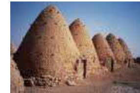
Architecture saharienne en terre (isolant).
