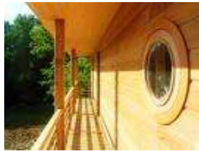
Avancées de toit, auvents, avant-toit « casquette », contre le rayonnement solaire direct
