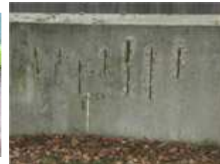
Exemples de corrosion marine du béton.
