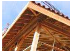
Avancées de toit, auvents, avant-toit « casquette », contre le rayonnement solaire direct
