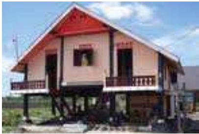
Maison construite par ONG musulmane à Aceh (Indonésie) avec l'aide de la société de construction ARUP www.arup.com
