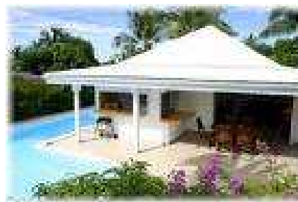
Maisons créoles ou tropicales avec toits clairs, avancées de toit, auvents, contre le rayonnement solaire direct.
