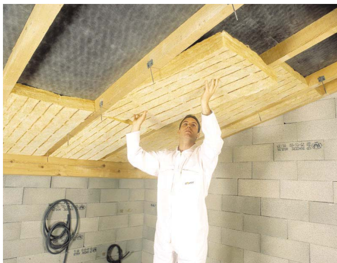
Mise en place de panneaux de laine de verre
