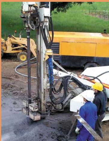
Pose d'une sonde géothermique
