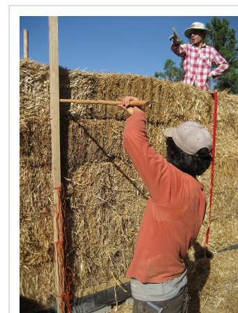
Construction d'une maison en paille.
