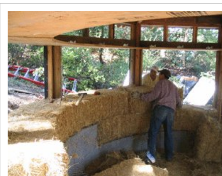
Construction d'un mur incurvé en ballots de paille.
