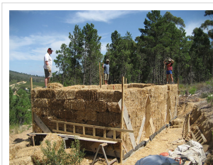
Construction d'une maison : murs porteurs en paille.
