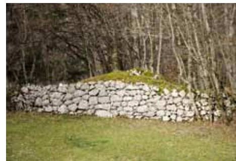
● APPAREILLAGE DE GROS MOELLONS CALCAIRES
