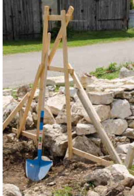
● GABARITS UTILISÉS SUR UN CHANTIER DE FORMATION
