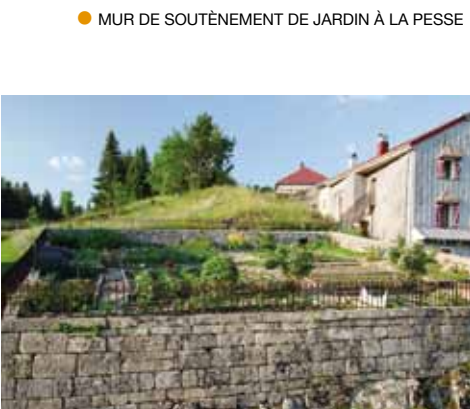
● MUR DE SOUTÈNEMENT DE JARDIN À LA PESSE
