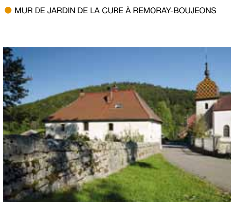
● MUR DE JARDIN DE LA CURE À REMORAY-BOUJEONS
