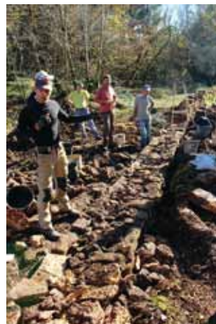
● QUELQUES ÉTAPES DE LA RESTAURATION : POSE DES PREMIERS LITS DE PIERRES, REMPLISSAGE ET POSE DU COURONNEMENT (CRÉDIT PHOTO : E. CHAULACEL / PNRHJ)
