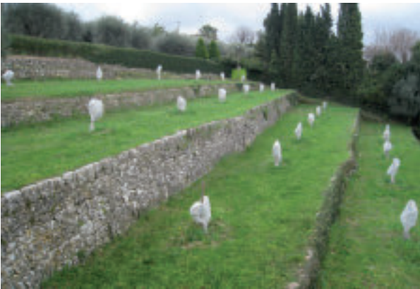
Des murs hauts et des terrasses étroites pour aménager une pente forte, Plascassier - Grasse. Marie Gautier, CRPF.
