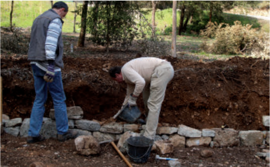
Construction d'un mur en pierres sèches, Auribeau-sur-Siagne, CAPAP.
