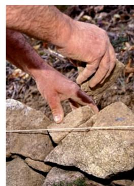
La construction d'une structure de soutènement en pierre sèche ne s'improvise pas, elle nécessite de connaître la nature du remblai (terres)
