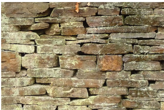
Lieu non précisé : parement d'un mur réalisé en pierres plates posées dans le sens du lit de carrière et avec croisement des joints.
