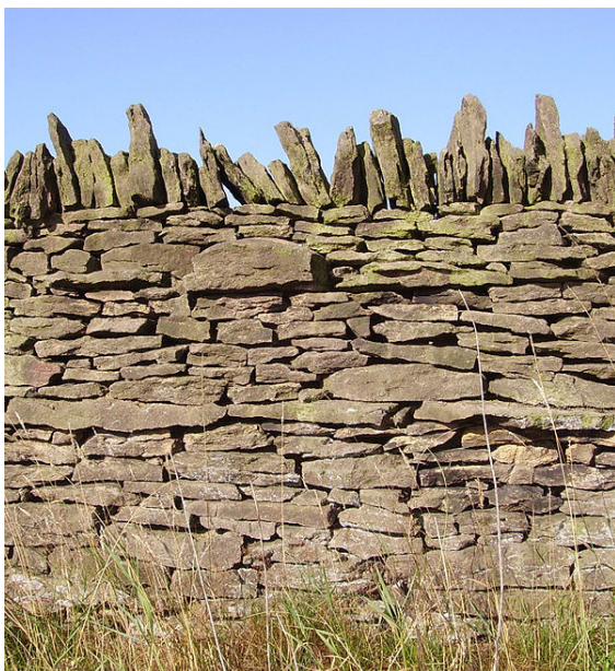
Yorkshire, Grande-Bretagne : parement laissant voir deux rangées de boutisses parpaings saillantes.
