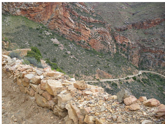
Mur de pierre sèche pour le soutènement de la route en lacets du col du Swartberg en Afrique du Sud.
