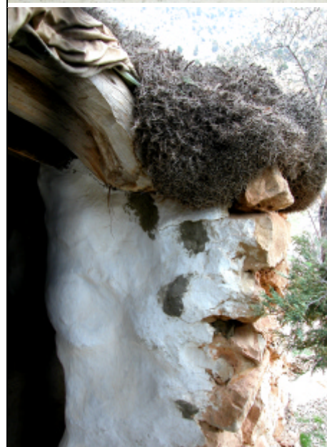
La baie et son encadrement : jambages
