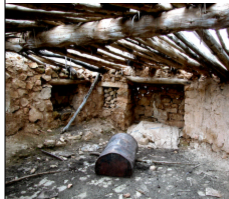
Liaison mur toiture
