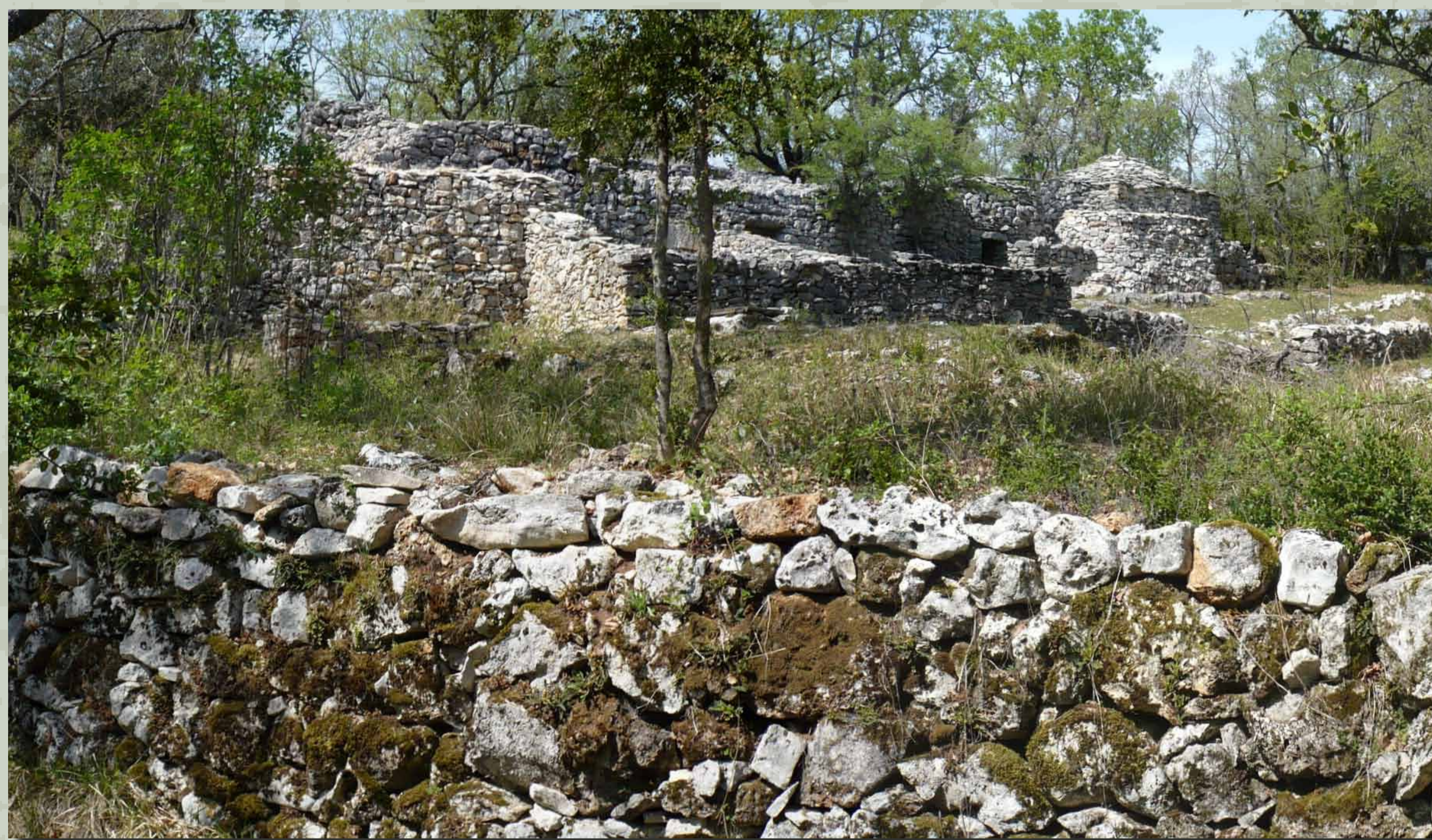
• Bergerie de Pié gros à Villes sur Auzon où ces espèces peuplent les murets
