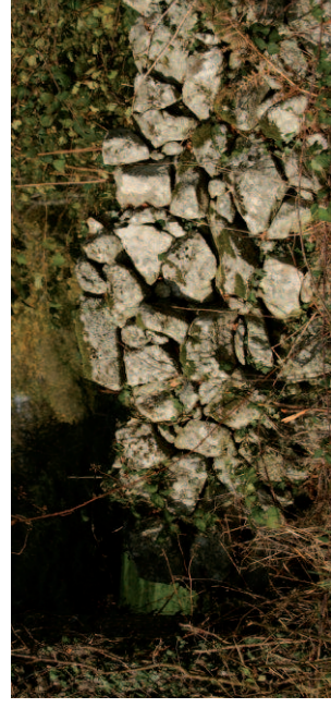
* Boutisses : Les boutisses sont des pierres qui montrent leur plus petite face et traverse une grande partie du mur, afin d'en assurer la cohésion. Une boutisse qui traverse le mur de part en part s'appelle un parpaing.
