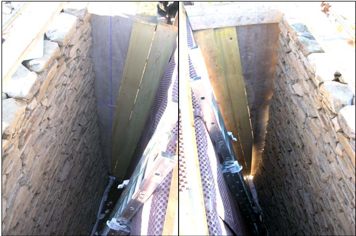
Figure V-14 : à gauche, profil final du parement interne du côté droit du mur 5, relevé par mesure manuelle à la fin de l'essai ; à droite, idem pour le côté gauche du parement interne.
