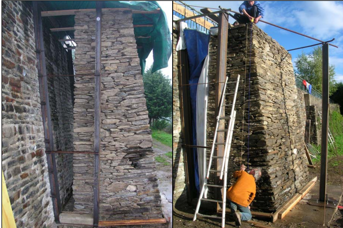
Figure V-5 : à gauche, mur construit avec profilés métalliques pour la pose du coffrage; à droite, pose de la bâche de chargement protégée par des plaques fines de polystyrène et par du géotextile non-tissé (bidim).
