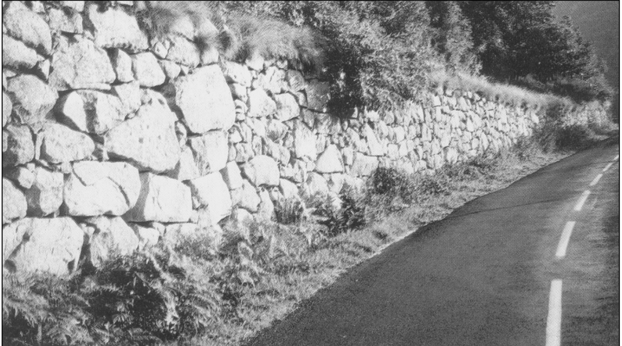
Figure I-5 : mur de soutènement routier granitique en pierres sèches (Ardèche).
