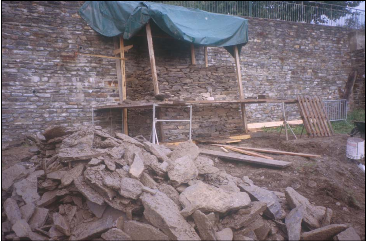
Figure V-3 : étape intermédiaire de la construction avec vue de l'hétérogénéité des pierres de construction.
