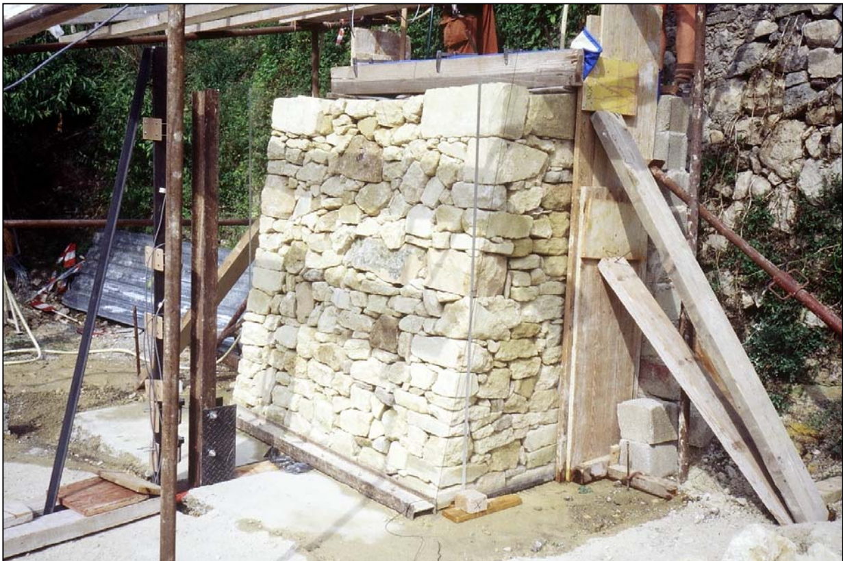
Figure IV-3 : mur 1 prêt à être expérimenté.
