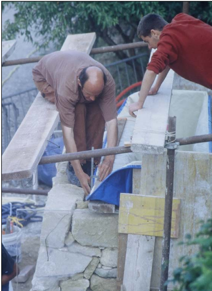
Figure IV-15: installation de la bâche de chargement d'eau pour le mur 1.
