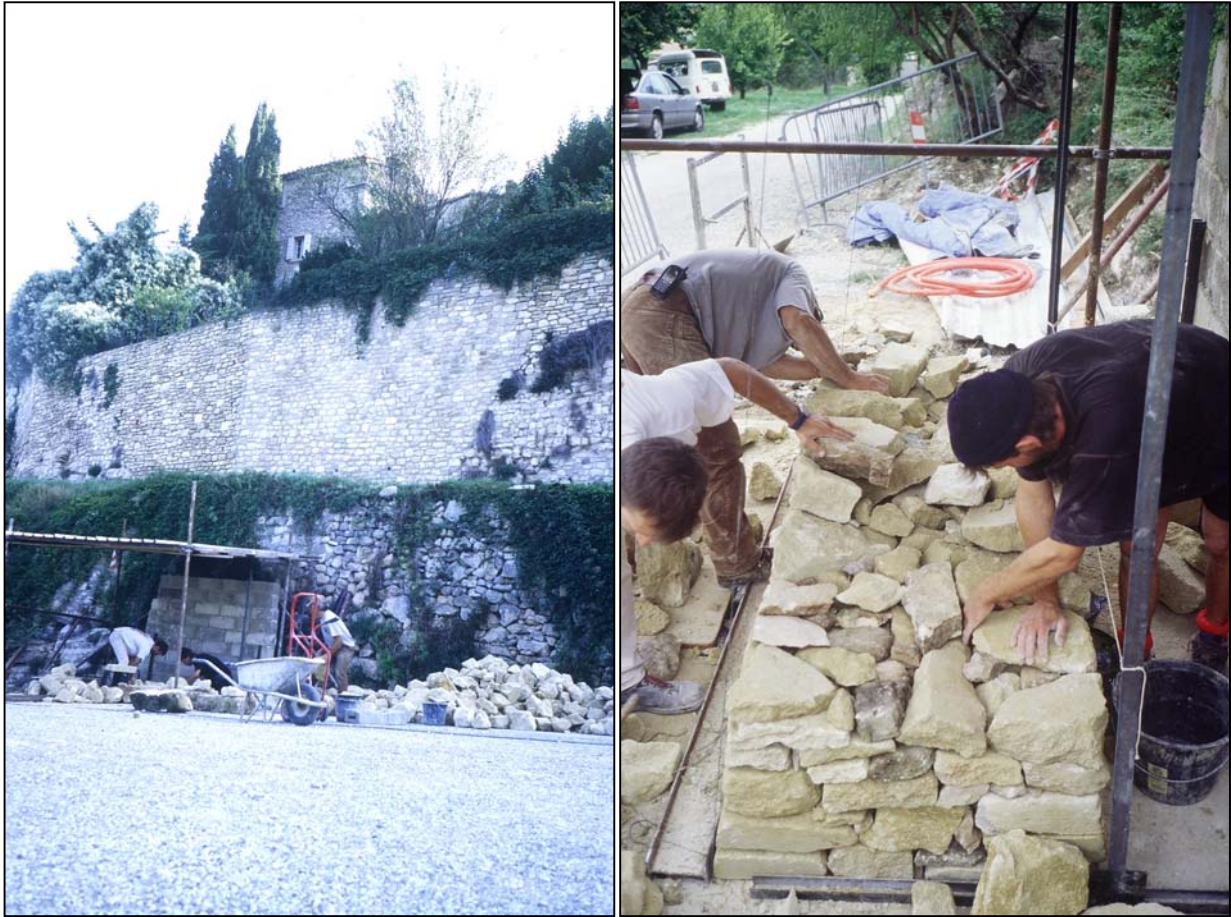
Figures IV-1 et 2 : construction du mur 1 au village du Beucet (1) avec vue sur le calage d'une pierre (2) .
