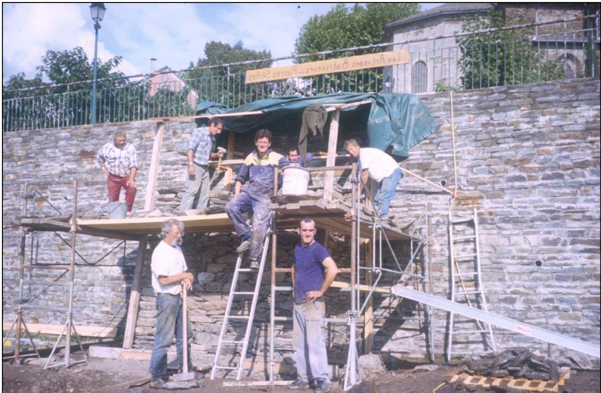
Figure V-4 : artisans bâtisseurs en pierres sèches à l'œuvre.
