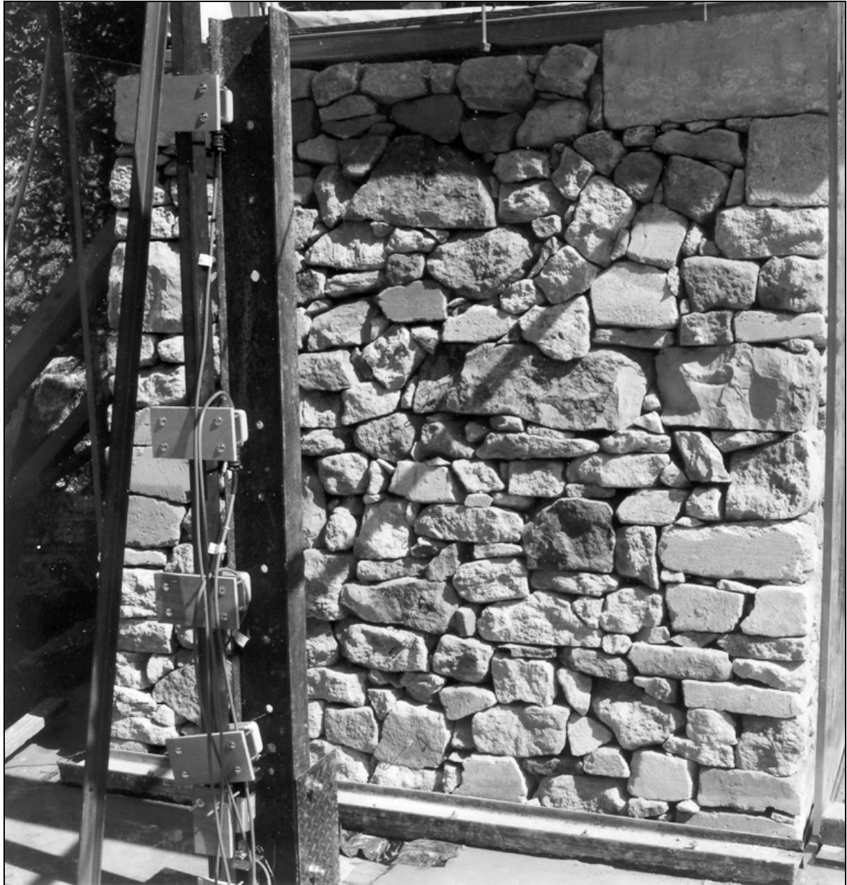
Figure IV-13 : poteau supportant les capteurs de déplacement à câble pour le mur 1 vu de face.
