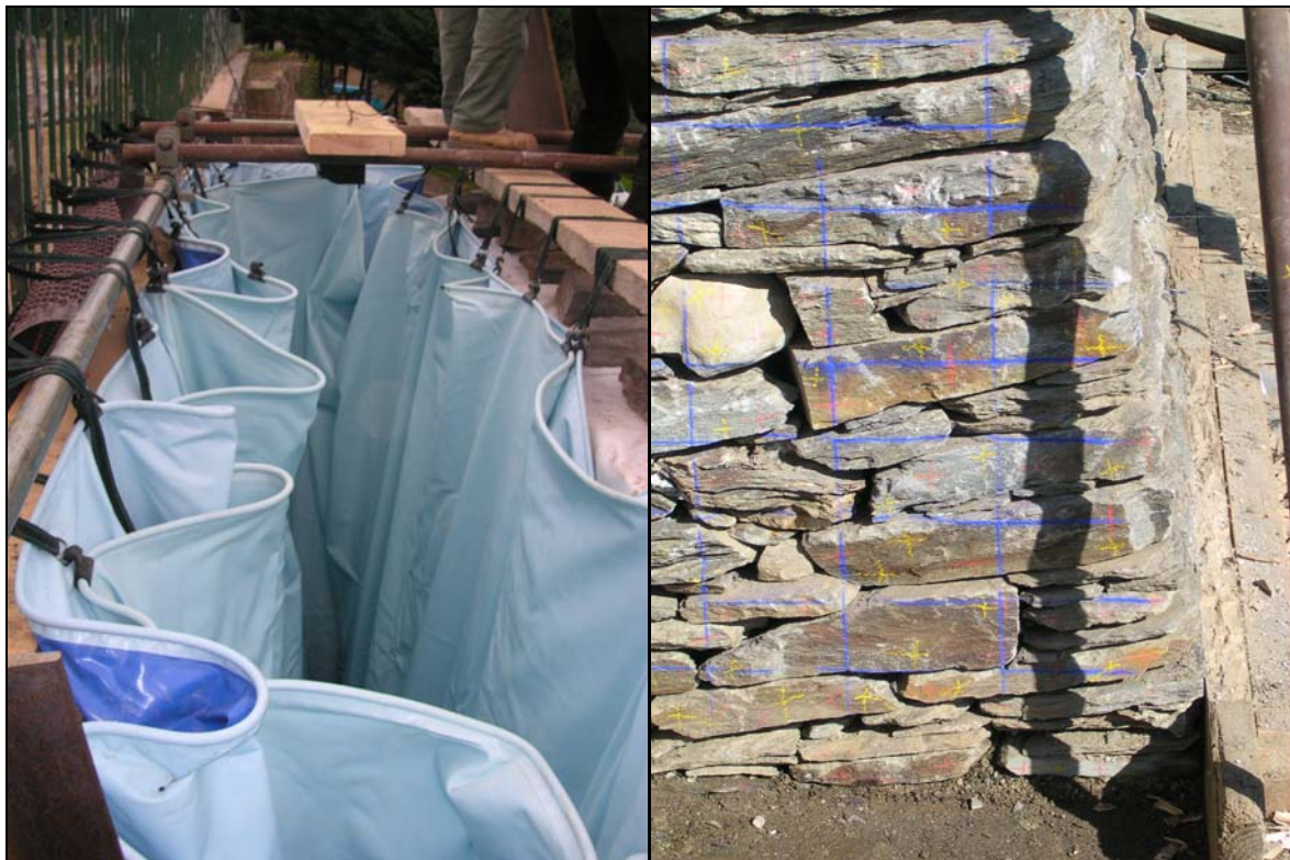
Figure V-6 : à gauche, fin de pose du dispositif de chargement (vue sur la bâche en PVC, sur le liner et sur le capteur de niveau d'eau); à droite, marquage du mur pour faciliter l'analyse stéréophotogrammétrique.
