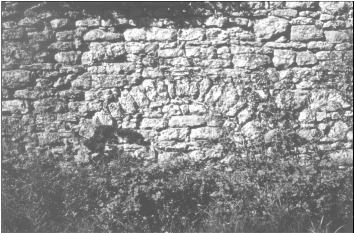
Figure I-1: mur de soutènement en pierres sèches du Vaucluse avec un arc de décharge.
