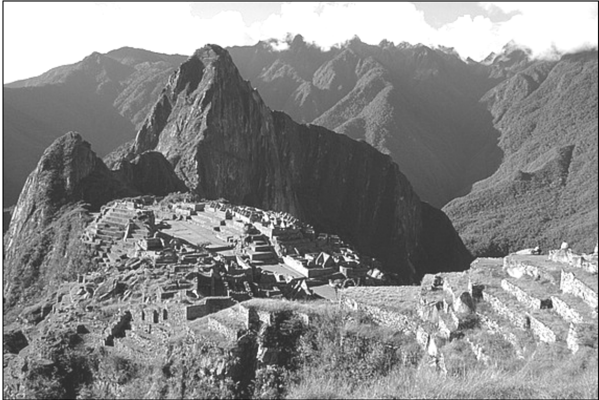
Figure I-3 : murs de soutènement en pierres sèches de taille à Macchu Pichu (Franck Zecchin 1996-2003).
