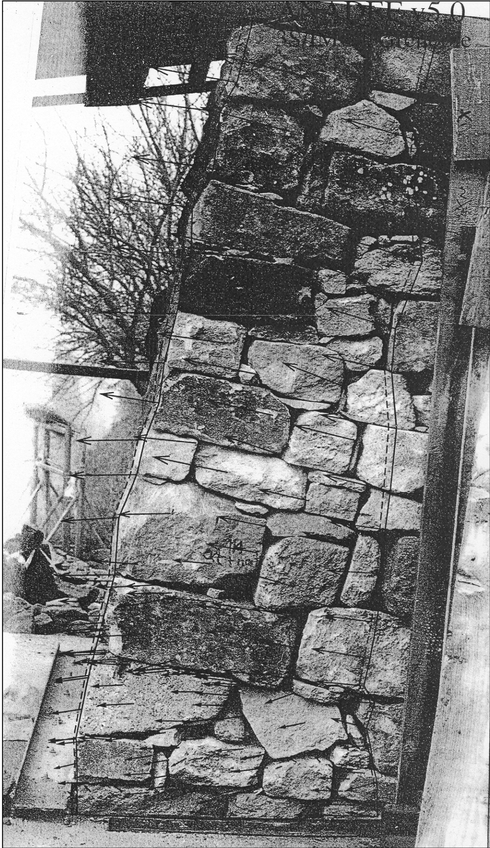
Mur 4, semis des vecteurs déplacement du couple 01-05.
