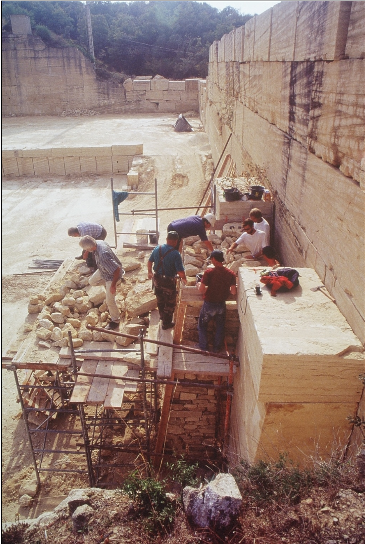
Figure IV-4 : construction du mur 3 et vue sur le coffrage latéral (blocs de carrière de St-Gens).
