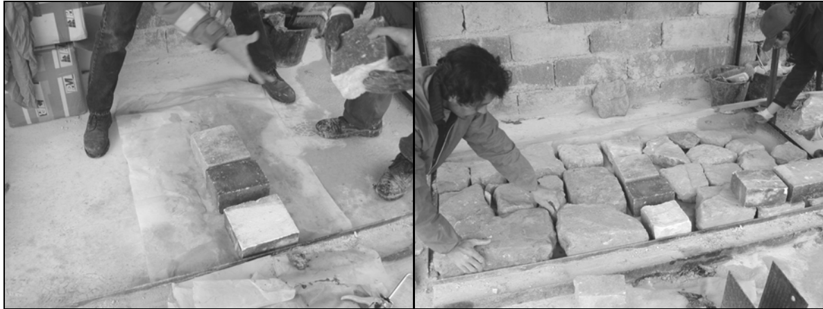
Figure IV-10 : montage des pierres sur les plaques après avoir posé l'étanchéité des capteurs (mur 4).
