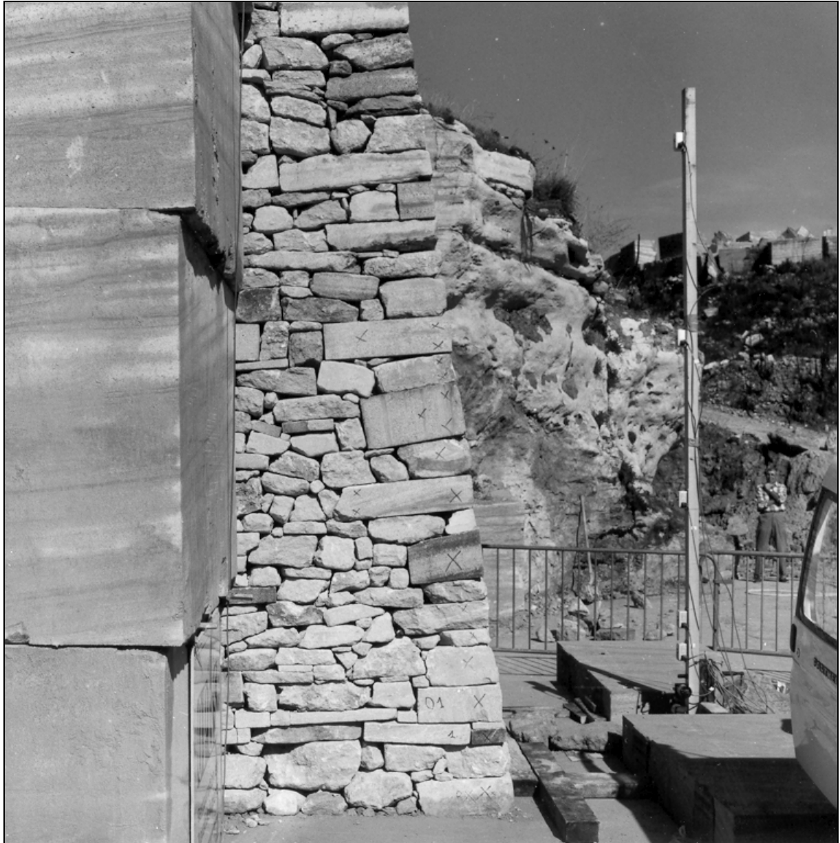
Figure IV-14 : poteau supportant les capteurs de déplacement à câble pour le mur 3 vu de profil.
