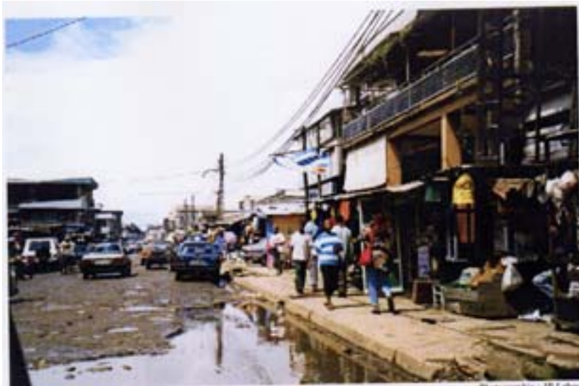
Photo12 : Une rue complètement défoncée presque exclue de la circulation dans la zone de Kououloun. Les fortes précipitations sont l'une des causes de la dégradation des routes à Douala.
