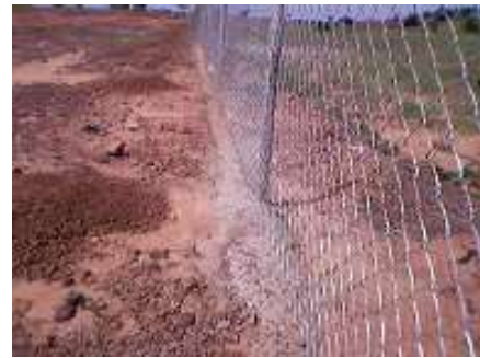
Posé par une machine à grillage, pour clôturer le futur Centre d'Education de Base Non Formelle (CEBNF), à Tougouzague au Burkina Fasso © Claire-Marie-Madeleine Péhi-Verny..
