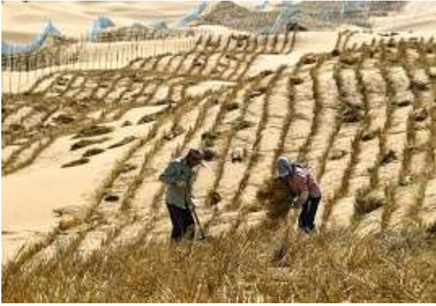
Photo, prise le 7/09/2020, montrant des travailleurs, fabriquant des barrières de paille, disposés en damier, pour la lutte contre la désertification, dans le désert de Tengger, le long du chantier de construction de la section Qingtongxia-Zhongwei de l'autoroute Wuhai-Maqin dans la région autonome du Ningxia Hui, dans le nord-ouest de la Chine. (Xinhua/Feng Kaihua).
