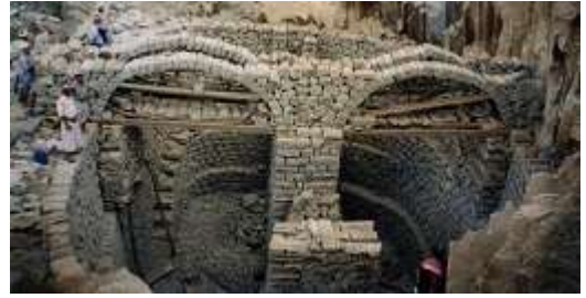
Construction d'une citerne en Syrie
