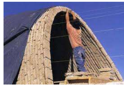
Maisons réalisées par la technique de la voûte nubienne (qui conservent la fraîcheur dans les pièces, en son sein).
