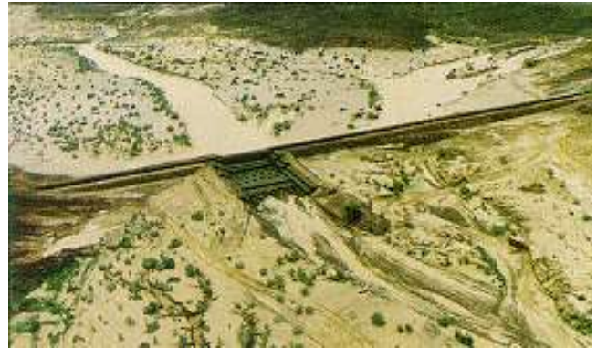
Construction de digues pour faire des retenues d'eau ou des barrages (Tout dépend du régime des pluies, de celui des crues et de la porosité du sol, localement).
