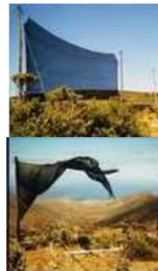
Il faut que les filets soient solidement arrimés au sol. Des filets à nuages sur la crête d'El Tofo (Chili) [un mauvais choix], Stephen Dale, IDRC 182 .
