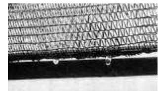
Vue de la gouttière qui recueille l'eau condensée.
