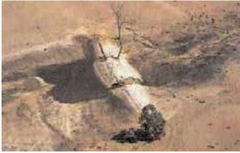
Barrage détruit à cause d'un déversoir [« spillway »] insuffisant.
