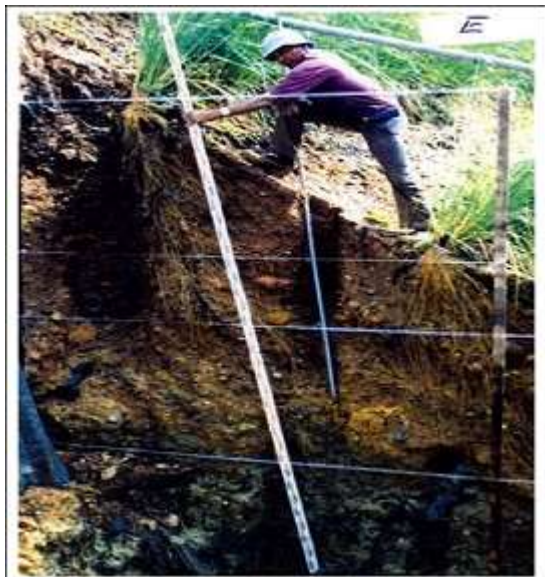
Coupe verticale sur un remblai montrant une croissance racinaire de 3,6m pour un vétiver de 8 mois.
