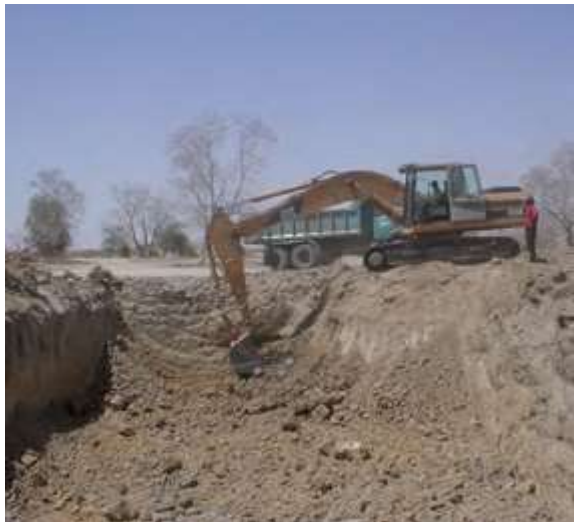
Construction d'une mare dans la région de Ouaddai © Projet Almy Bahaim (2008).
