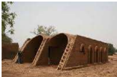
Maisons réalisées par la technique de la voûte nubienne (qui conservent la fraîcheur dans les pièces, en son sein).
