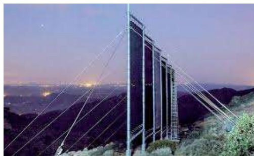
Le projet est composé de 600 m 2 de filets capteurs, deux citernes de 500 m 3 , un puits de forage, 9.000 m de canalisation et 20 branchements domestiques, au sommet du Boutmezguida (Maroc) 187 .
