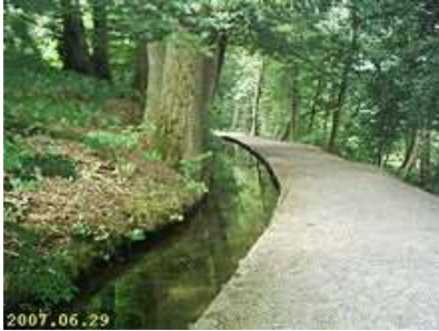
Depuis des siècles ou millénaires, des canaux d'irrigation (ex. : « biefs ») ont été construits presque perpendiculairement aux pentes pour transporter l'eau, parfois dès la haute montagne.
