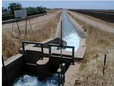
Canal d'irrigation à Osmaniye, Turquie .
