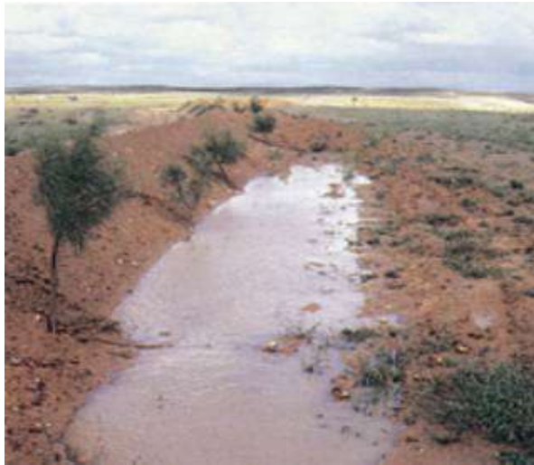
Système liman : par cette levée de terre, les eaux de ruissellement sont détournées vers des canaux (Kenya).
