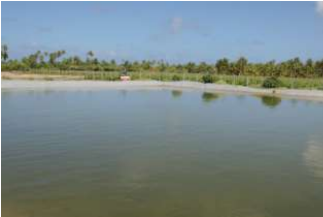
Installer des réservoirs d'eau (pour l'irrigation et la lutte contre le feu) . Étanchéité réalisée avec une couche d'argile ou un géotextile étanche.
