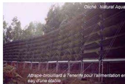
Attrape-brouillard à Tenerife, pour l'alimentation en eau d'une étable 185 .
