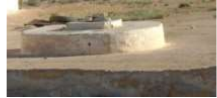
Citerne pour la collecte des eaux pluviales pour l'alimentation en eau potable (zone de Ksar Jedid - Medenine - Tunisie).
