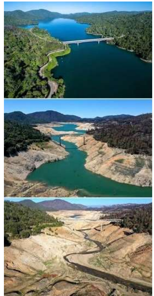
Le lac d'Oroville en Californie est rempli à seulement 35 % de sa capacité. La première photo date d'il y a 3 ans. La 2e photo a été prise le 27 avril 2021. La 3e a été prise en août 2021 33 .
