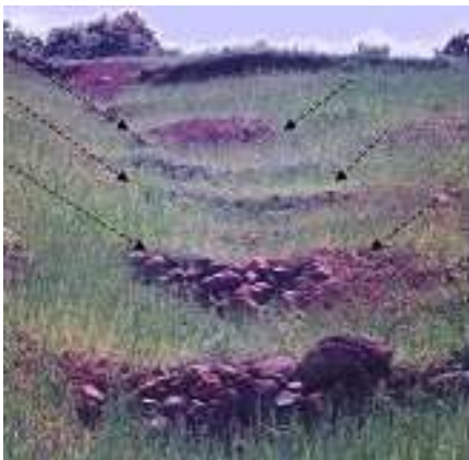
Ravin aménagé dans un champ de céréale : seuils en pierres sèches 165 .
