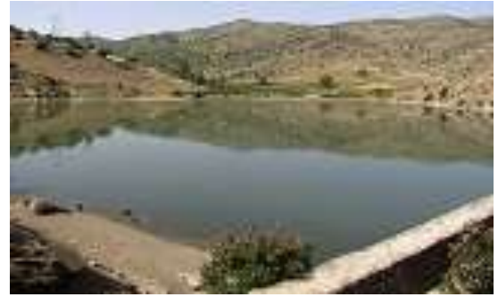
Lac collinaire dans la région nord Marocain installé pour contrer le problème d'envasement d'un barrage en aval 164 .
