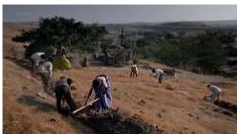
Creusement de la baissière ou du canal.
