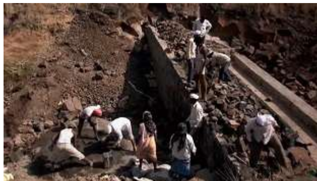
Vérification du barrage.
