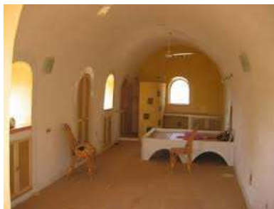
Maisons réalisées par la technique de la voûte nubienne (qui conservent la fraîcheur dans les pièces, en son sein).
