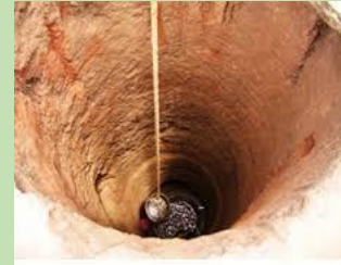
a) Creusement manuel d'un puits à Madagascar.
