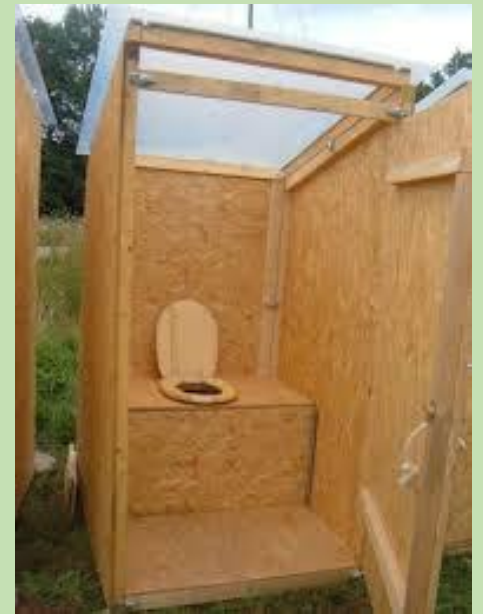
Toilette sèche. Source :
