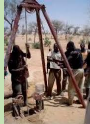
a) Creusement manuel d'un puits à Madagascar.
