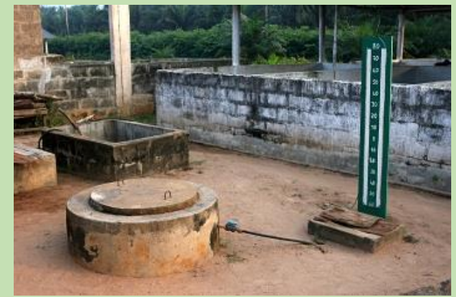
Cuve à fermentation – biodigester.
