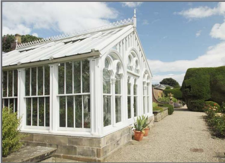
Le toit d'une véranda peut être transparent, mais pas nécessairement. Réalisé en verre, en matériaux de synthèse tels le polycarbonate, il est aussi plus ou moins épais. Il peut également recevoir des panneaux opaques si l'on recherche une protection thermique importante ou même une couverture en matériaux
