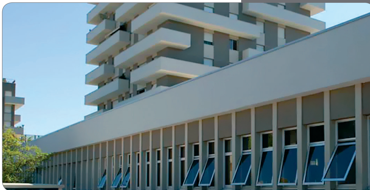
Maison départementale des personnes handicapées des Hauts-de-Seine
