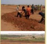
Principe on créé des très grandes demies lunes sur de larges surfaces dénudées, endurcies ou encroûtées. Il s'agit d'ouvrages présentant un bourrelet non franchissable, un gradin et un fossé. La banquette finie mesure 80 ml et 70 cm de profondeur. Les banquettes sont disposées en quinconce et l'interlignes est de 30 m. Elles vont collecter les eaux qui ruissellent sur les espaces nus.
