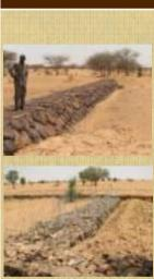
Principe C'est un ouvrage pierreux construit au travers d'une zone de ruissellement fort. Il doit être toujours être ancré dans le sol (fondation). D'une hauteur moyenne de 0.5 à 0.8m, la largeur de la dique dépend du débit maximal du ruissellement qui doit la traverser. Plus le courant est important, plus il faut prévoir d'enchaînement de digues.
