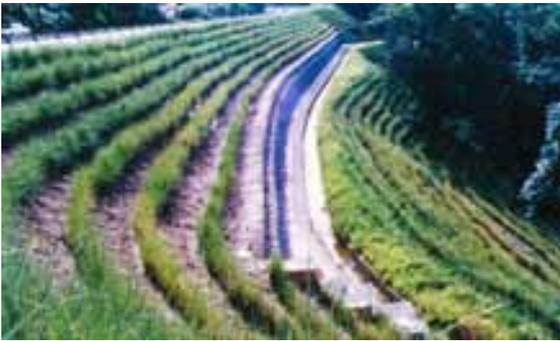
Le mur d'un grand barrage protéger et renforcer par des haies de Vetiver. Avec un développement rapide le vétiver stabilise et fortifie sols et les murs de bassins
