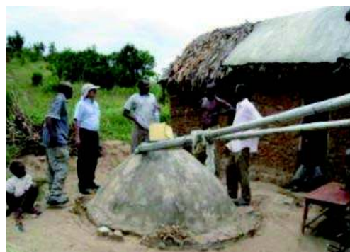
Toit en matière organique couvert de plastique avec réservoirs partiellement enterrés, en zone rurale, Ouganda (Danert et Motts, 2009).
