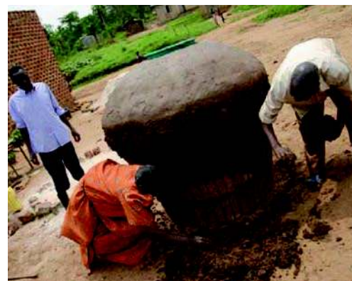
Un couple en train de construire une cuve près de leur maison dans un village en Ouganda. (WaterAid / Caroline Irby)
