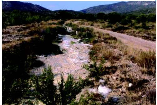
Système traditionnel de canaux (acequia) amenant l'eau de crue (avec des diguettes en terre ou en pierre) depuis des ruisseaux intermittents vers des terrasses d'amandiers, Espagne. (J. de Vente)
