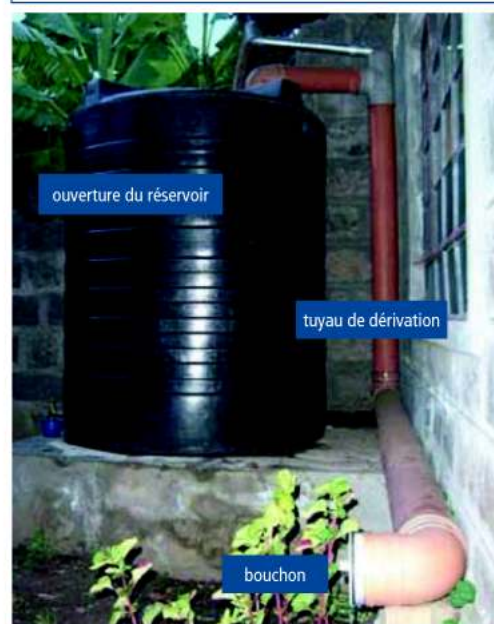
Cuve en plastique avec un système à effet de chasse, Kenya (Stevenson, 2007 dans Doyle, 2008).
