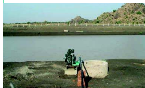
Système de hafir amélioré avec une pompe à eau et un réservoir à sédiments (Ministries of Water Resources and Irrigation of Sudan and South Sudan, 2009).
