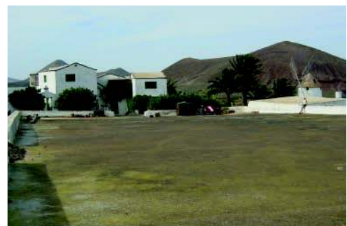
Installation de collecte de l'eau dans une cour ou une surface compactée à Lanzarote, Archipel des Canaries. (W. Critchley)
