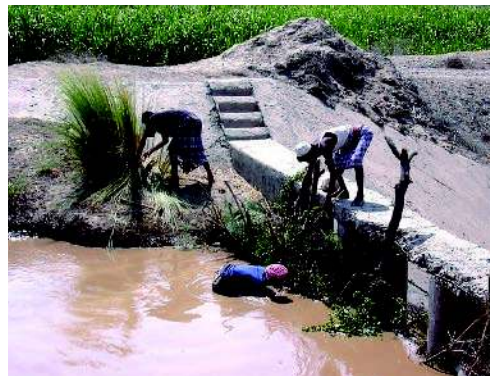
Blocage de l'écluse de nettoyage sur un système d'irrigation de crue modernisé au Yémen. (spate-irrigation.org)
