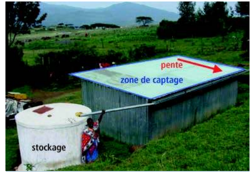
Captage de toit au Kenya, montrant les différents éléments d'un système de ToitsCE. (M. Malesu)
