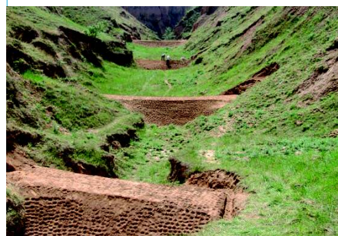
Barrages à rétention de sédiments ( warping ) dans le comté de Xifeng, province de Gansu après construction des structures. (L. Xiaobo)
