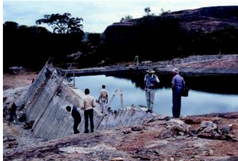
Construction d'un barrage à collecte rocheuse à Kitui, Kenya. (HP. Liniger)
