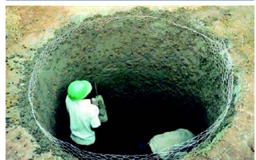
Réservoir souterrain pour la récolte d'eau d'un cour et d'une route au Kenya. Ce réservoir a été équipé d'un piège à sédiments et est utilisé pour stocker l'eau de ruissellement (Nissen-Petersen, 2007).
