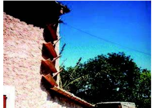
« Gouttières en cascade » d'un système ToitsCE pour l'usage domestique à Majorque, Espagne (Barron, 2009).
