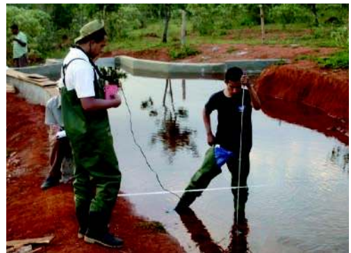
Construction d'une petite retenue d'eau au Brésil. ( www.smallreservoirs.org )
