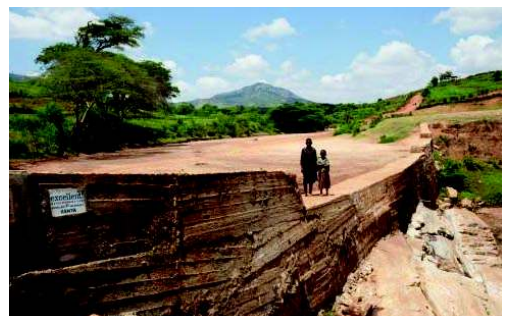
Barrage de sable rempli dans la vallée de Nzyaa Muysio au Kenya. (P. Braden)
