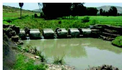
Digue de contrôle en pierre, béton et gabions pour l'irrigation. Elle permet en même temps de réduire la vitesse du ruissellement et de favoriser la réhabilitation de la ravine. (E. Yazew)
