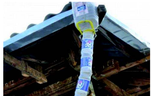
Une descente de gouttière en bouteilles plastique recyclées et cousues ensemble avec du fil de fer fin dirige l'eau vers un réservoir en béton, Boshkengash, Tadjikistan. (S. Stevenson)
