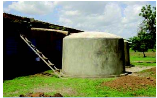
Un réservoir en ferrociment près d'une école locale au Burkina Faso. (WaterAid / Chris Leake)
