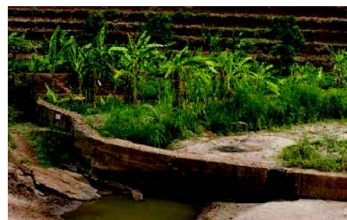
Des bananiers derrière un barrage de sable. (excellent développement)
