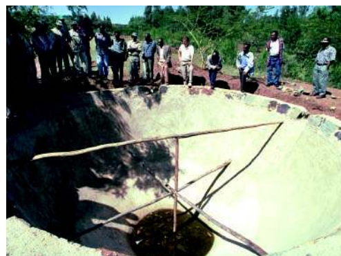
Réservoir souterrain revêtu de ciment, en cours de construction, Ethiopie. (HP Liniger)
