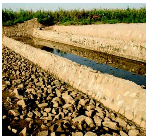
Seuils d'épandage des crues construits en série (GIZ, 2011).
