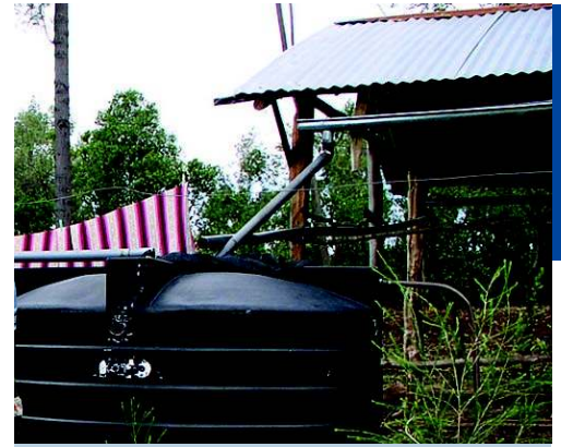
Gouttière en demi-cercle avec descente de gouttière ronde. (C. Studer)
