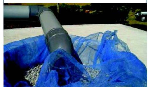
Un filtre en filet, sable et gravier, utilisé au Karnataka, Inde (Rainwater Club, non daté).
