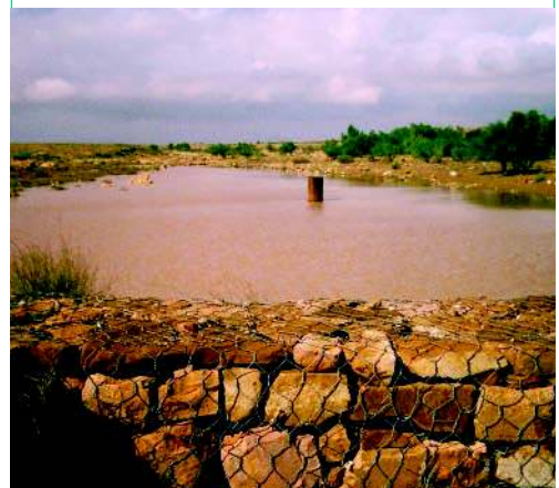
Exemple d'un puits filtrant derrière une retenue en gabions, après la pluie. (M. Ouessar)
