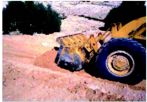
Construction mécanisée d'une digue de tabia , Tataouine, Tunisie. (M. Ouessar)
