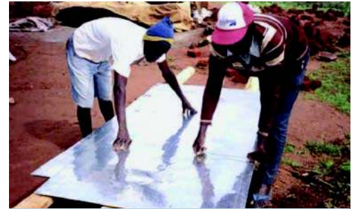
Fabrication de gouttières à section carrée avec de la tôle galvanisée : pliage autour d'une pièce de bois (Nissen-Petersen, 2007).
