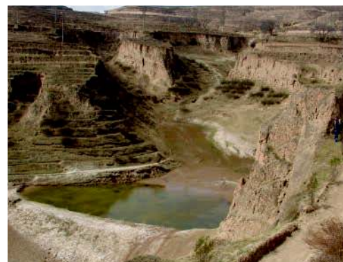
Barrage en terre sur le plateau de Loess, Chine. (HP Liniger)
