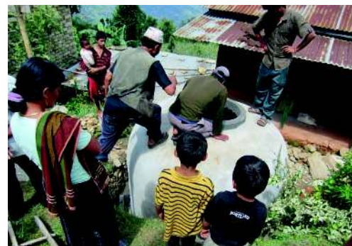
Une cuve de stockage de l'eau de pluie construite par des ménages au Népal. (RAIN)
