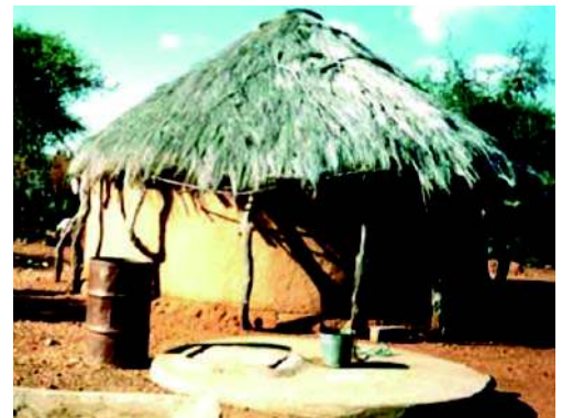
Système de ToitsCE avec collecte d'eau de pluie sur un toit en matière organique. (infonet-biovision.org)
