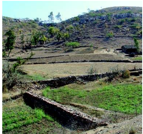
Digue filtrante en pierre, Rajasthan, Inde. (HP. Liniger)
