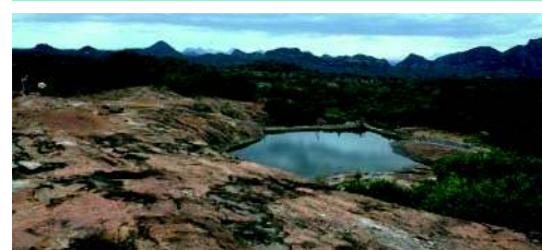
Barrage à collecte rocheuse à Kitui, Kenya. (HP. Liniger)
