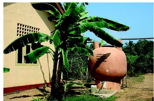
Réservoir en ferrociment au Sri Lanka. (inconnue)
