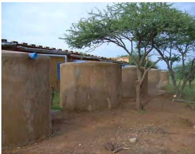
Photo 27: Système d'impluviums en ferrociment pour stocker l'eau
