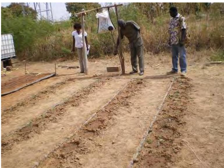
Photo 23: Installation de rampes d'irrigation goutte à goutte
