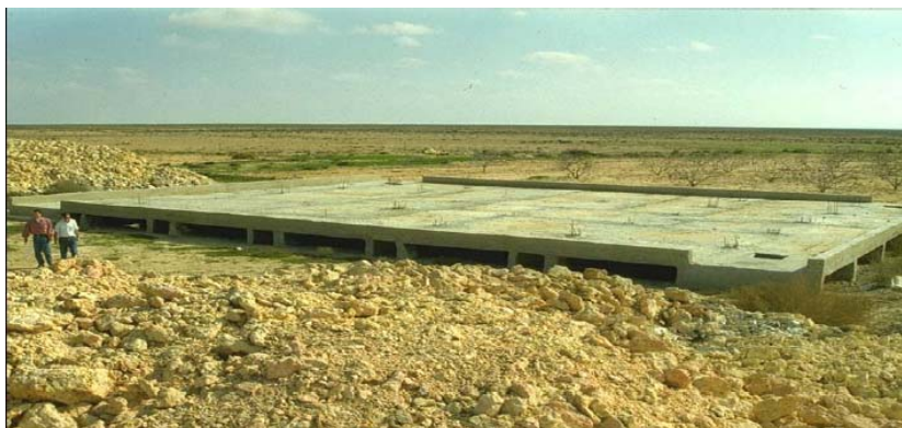
Citerne en ciment de capacité de 3000m 3 construite à Marsa Matruh au Nord-Ouest de l'Egypte
