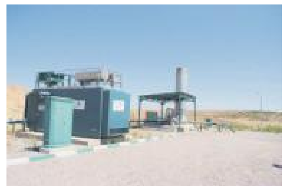
Station de production de Biogaz à Fes au Maroc
