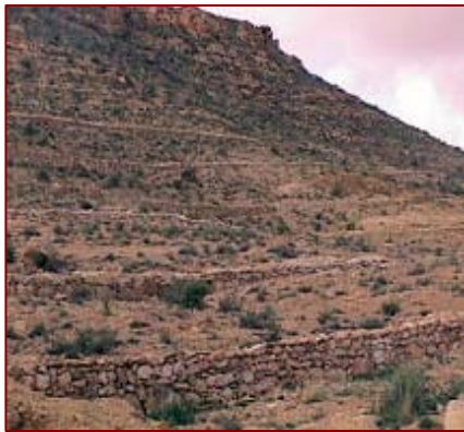
Des terrasses nouvellement installées à jebel of Tajra
