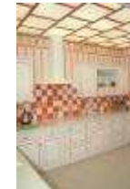
Fig.33. Plafond avec dalles plexiglass
