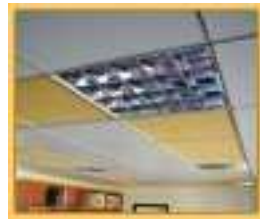
Fig.31. Faux-plafond avec aération
