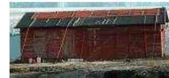
↑ Certaines cabanes d'expéditions arctiques sont haubanées pour résister aux forts vents (voir page suivante).
