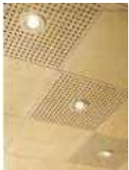
Fig.30. Plafond avec luminaires
