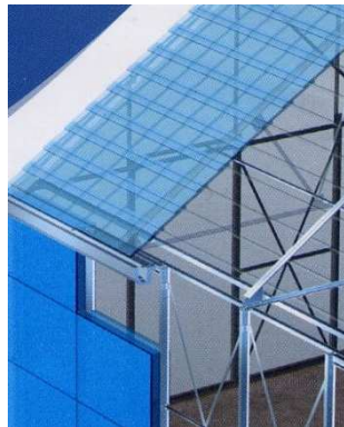
Solution de renforcement de la structure face aux contraintes par chaînage-croisillons (solution ® Geoxia/ Maisons Phenix brevetée).
