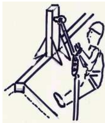
Fig. 169c2. Le propriétaire, en même temps monteur de la maison, devient « cordistes » après une formation dans les locaux de formation de la société « Evolutive House® ». Il est attaché à un anneau à un poteau faitier (bien monté).
