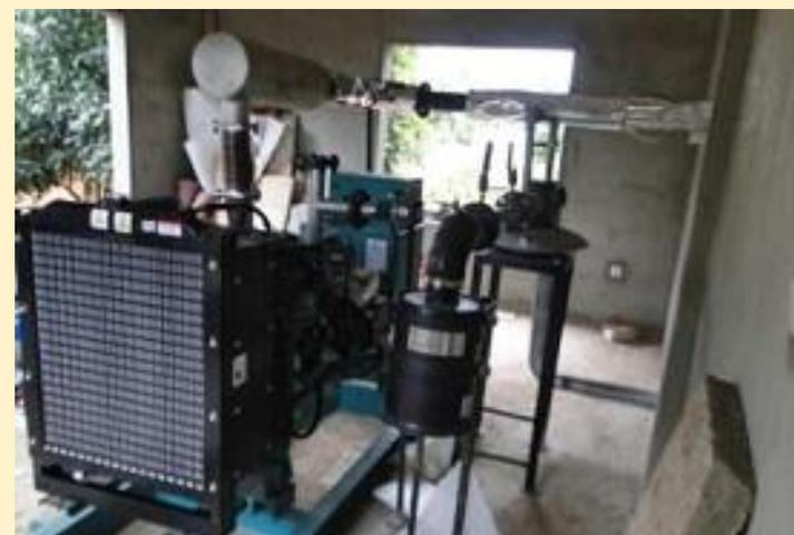
↑ Générateurs (groupes électrogènes fonctionnant au gaz, produit par l'unité de gazéification ou de pyrolyse)
