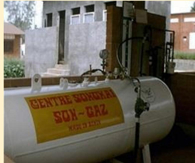
Réservoirs de stockage du biométhane purifié, débarrassé de ses impuretés (eau ...) ↑ ↗ →
