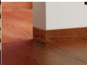
Pour finir la pose et dissimuler les joints périphériques de dilatation.
