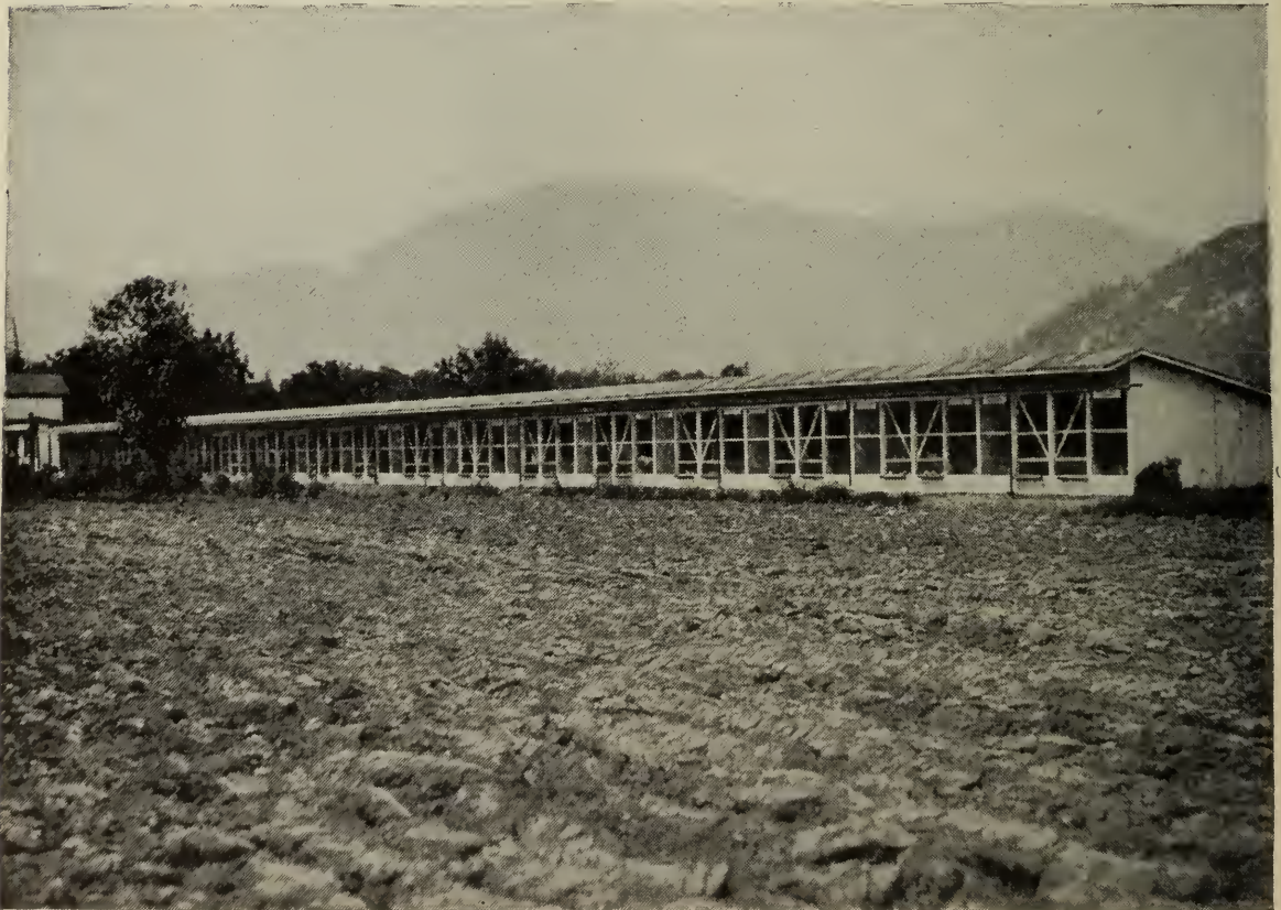
FIG. 9a.—Poulailler de concours permanent continu, ferme expérimentale fédérale, Agassiz, C.-B. A noter le devant ouvert et le toit en appentis, une construction typique dans la région de la côte du Pacifique (voir plan détaillé).
