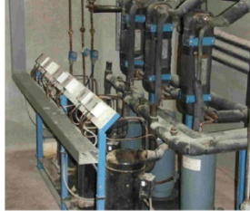
PAC sur eaux de lavage d'air
