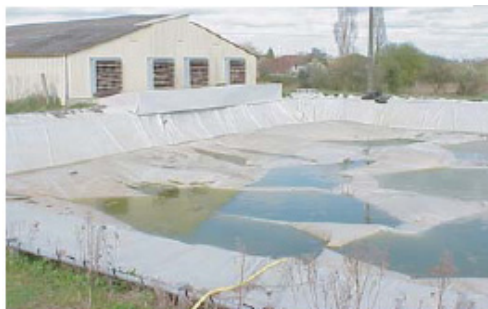
Exemple de couverture flottante
