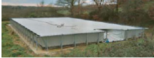
Exemple de couverture tendue à plat
