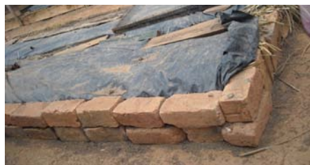
Au sol encadré par des briques doublées Sous sol
