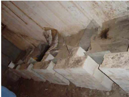
Fig. 6 : Lits de vers en blocs de béton de mâchefer à la ferme Scott
